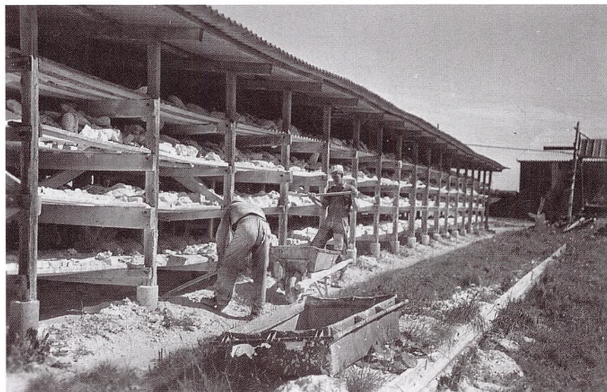
Tørrelade. Nogle gange blev kridt slam kørt fra bassinerne med trillebør ud til laderne og skovlet op på hylde 1 og 2.
