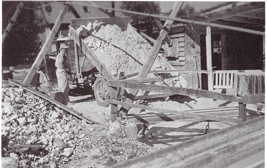
Kridtet tømmes ud i slemmen. Tipladet var mekanisk, d.v.s. ladet blev hejst op mekanisk. Lavet af smed Hangaard. I højre hjørne foruden ses kæder til harver og selve harvearrangementet.
