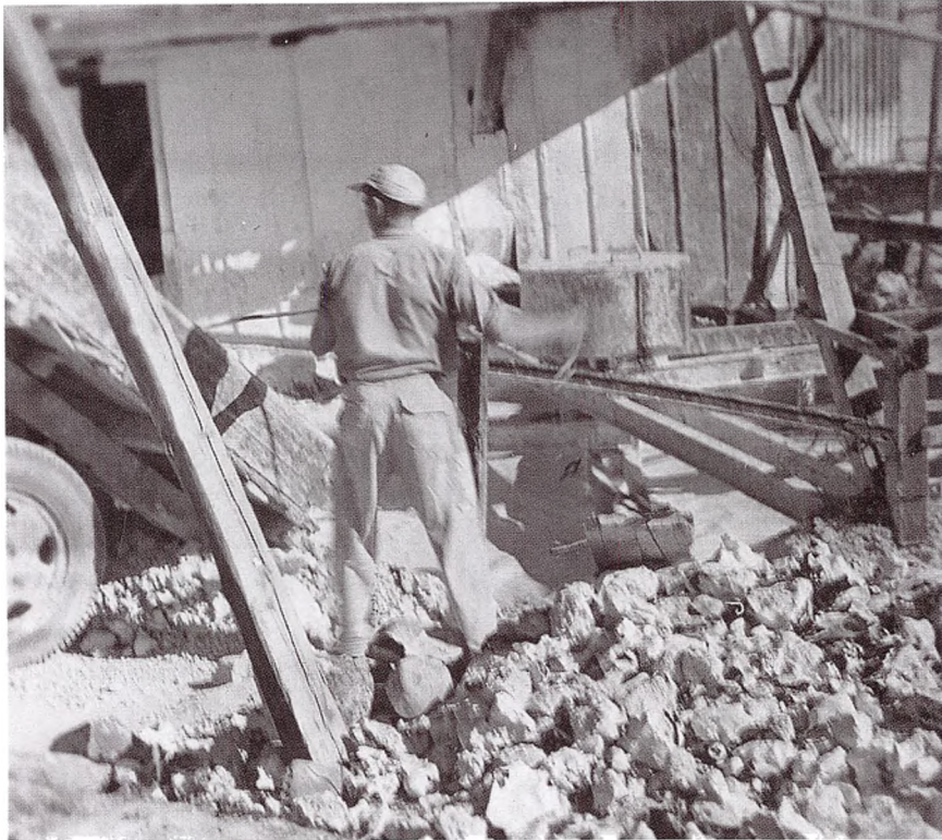
Nogle gange måtte kridtet skovles ned i slemmen. Lidt af harvearrangementet kan ses til højre. Midt i billedet ses gearkassen, der driver harven rundt. Den er købt i Hanstholm lige efter krigen.
