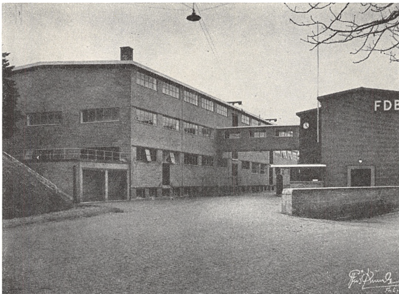
Indkørsel til Fabrikkerne i Viby. Til venstre et Hjørne af Rebfabrikkens Lagerbygning, og til højre Kontorbygningens Gavl.
