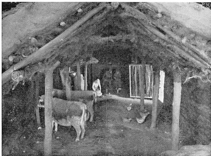
Tværsnit gennem en jernaldergård fra tiden omkring Kristi fødsel — tegnet på grundlag af de fundne stolpebuller, den sammensunkne tagkonstruktion og ydervæggene samt øvrige fund fra rummet. Kornbeholderen er en rekonstruktion af en kornbeholder fra Gindernup i Thy.
