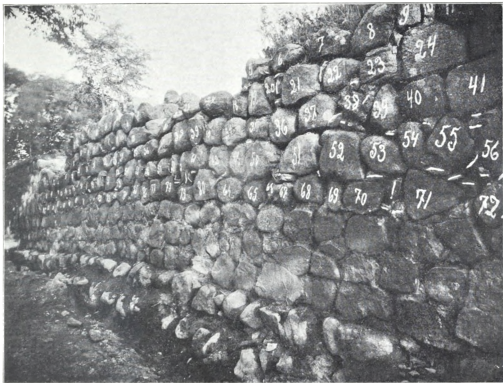
Fig. 3. Den ombyggede Borgs nordre Ringmur før Istandsættelsen i 1913. De løse Kampesten blev nummere- rede og fotograferede i en Række Frontfotografier, inden de nedtoges og atter indmuredes.
