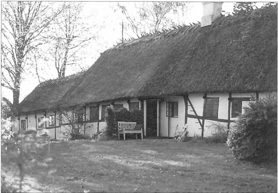
Stuehuset til Peder Povelsens nye gård fra 1763 som det står idag. Ved udflytningen af gården sidst i 1800-tallet blev længerne revet ned, men stuehuset blev stående tilbage.
