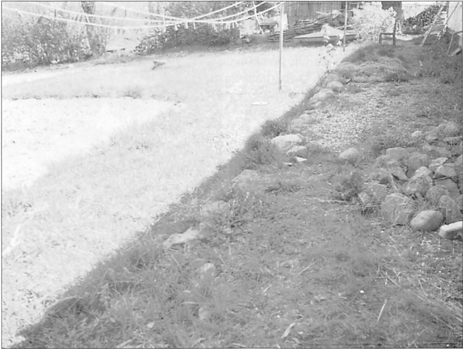
Fundamentsten ved Gl. Brorup.
