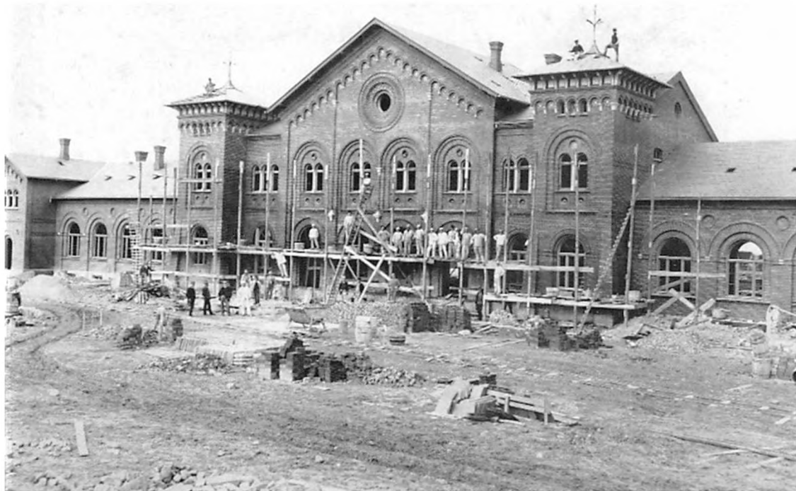
Illustration 4: Slagelse ny banegård under opførelsen 1892. Bemærk de manglende sikkerhedsforanstaltninger for arbejderne på taget. Foto fra Slagelse Lokalarkiv.
