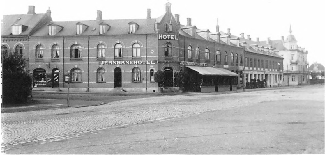
Illustration 5: Jernbanehotellet 1912 (nu Hotel Slagelse) på hjørnet af Sdr. Stationsvej og Sankt Mikkelsgade. Hotellet blev opført omkring 1900. I ejendommen efter fortovsmarkisen lå Missionshotellet, senere Centralhotellet. Foto fra Slagelse Lokalkiv.
