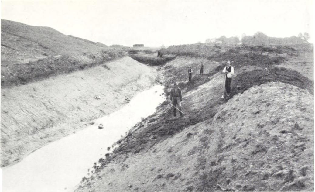
Fig. 2. Trelleborgs Voldgrav fremdrages som Beskæftigelsesarbejde.
