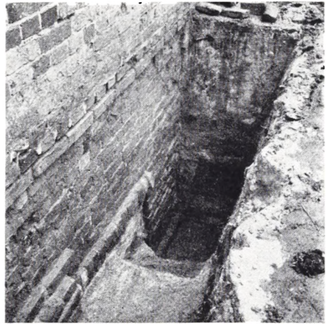
Fig. 53. Fundamenter ved stuehusets nordfacade.
