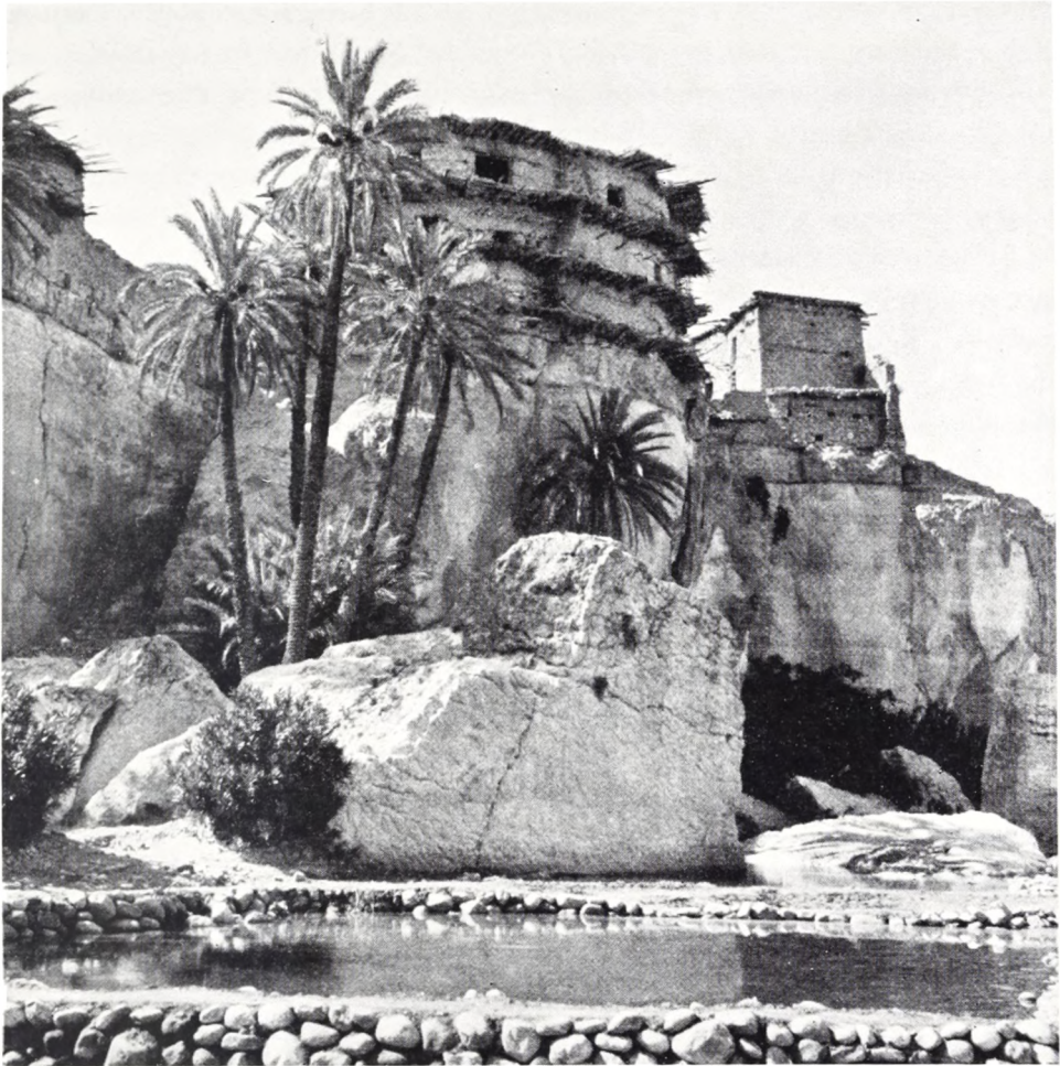
Fig. 7. Den kollektive kornlade ved landsbyen Baniane i det sydlige Aurès nær Sahara. Aabningerne i stenvuren angiver de enkelte familjerum. Hver etage har udvendige altaner af stolper og grene.
