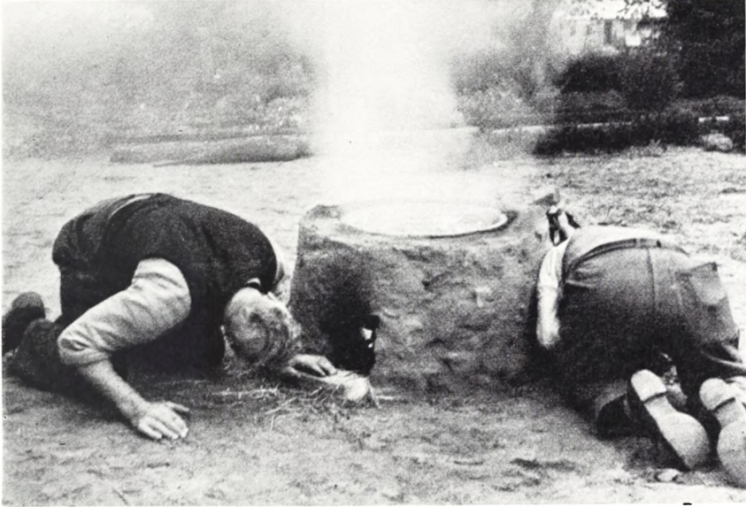
Fig. 2. Blydækker Bøjle Bøjlesen og hans medhjælper puster til ilden, medens de tænder op i den for tilfældet opmurede ovn ved Estvad kirke. Røgen trækker op omkring smeltediglen.
