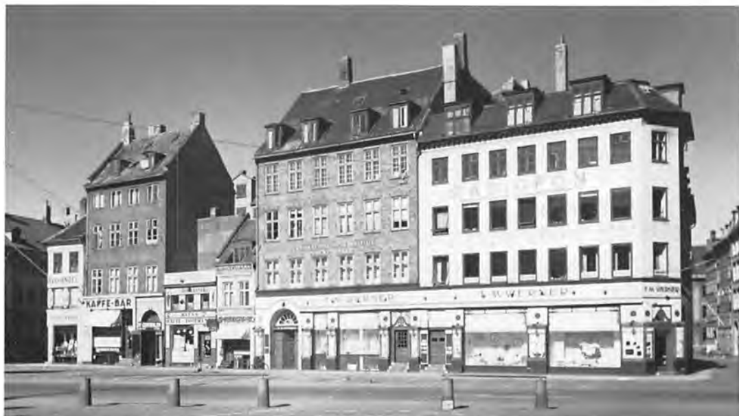
»Den grimme husrække« på Kulturvet med ryggen til Hauser Plads fik lov at stå helt til 1950erne, da hele karreen blev nedrevet. Det gjorde, at torvet i løbet af få år helt ændrede karakter. Det er Hausegade til venstre og Pustervig til højre. Foto 1948. – Hassing.
