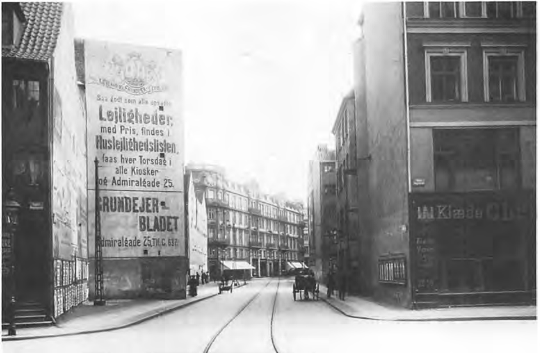
Ja, man er igennem, og selv om der ser farligt ud på de resterende facader til begge sider, har man travlt. Linje 7 sættes ind allerede i 1907. Her har fotografen stået ved Store Regnegade og set tilbage på det ældste og pæneste stykke af gaden fra 1873. – Foto 1918 fra Bymuseet.
