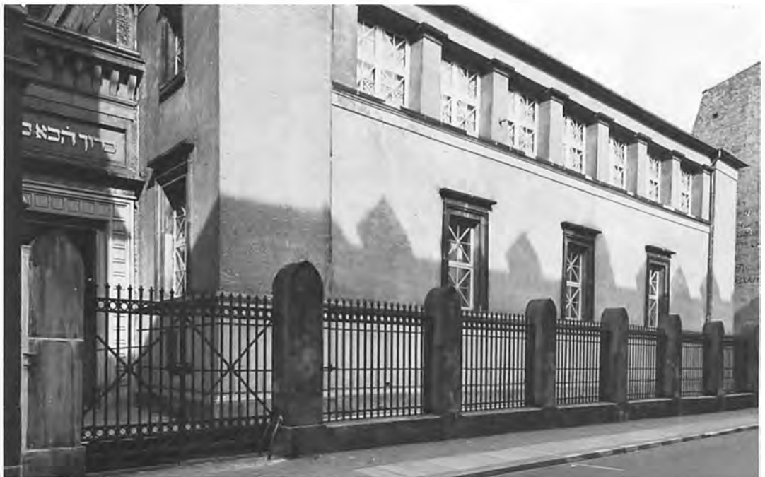
Synagogen set fra gaden. Forrest til venstre det porthus, der tilbyggedes i 1885, og som siden har dannet indgang. Det var denne port, der blev ødelagt ved terroristbombsprængning i 1985. Fot. 1949. – Hassing.
