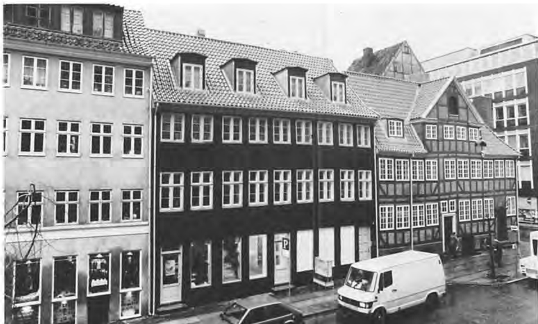
Gammel Mønt 37-39 og 41, ved hjørnet af Møntergade med Gutenberghus som nabo siden 1964. Vore dages private ejere af karreens ejendomme har kappedes om at sætte de gamle huse smukt i stand. Fot. 1980. – Stadsingeniørens Arkiv.
