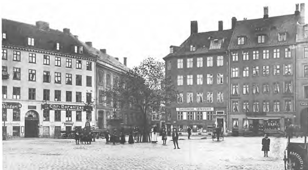
Her er et andet hjørne af torvet, hvor Pustervig slutter ved den korte Suhmsgade, der fører til Landemærket og fortsætter i Gutenberghus' nye udformning af nedre Pilestræde. Man genkender det store 11-fags hus i nr. 16 og skolen i Suhmsgade nr. 4. De to huse i Pustervig nr. 14 og 12 er opført 1835. Billedet er fra omkring 1900, da pladsen henlå i en temmelig reduceret stand. – Foto på Bymuseet.
