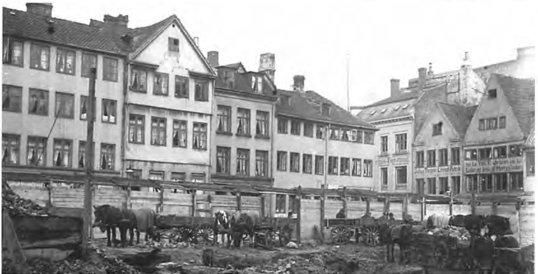
Den venstre side – de lige numre – af Antonigade er faldet for »Pilegården« og »Antonihus« og planerne om den nye Citygade. Det er nr. 15-23, man ser ligefor, og det er her Kvindelig Læseforenings sidefløj opføres i 1910. Til venstre de to gavlhuse i Kristen Bernikows Gade, som falder kort efter. – Foto 1899. Bymuseet.
