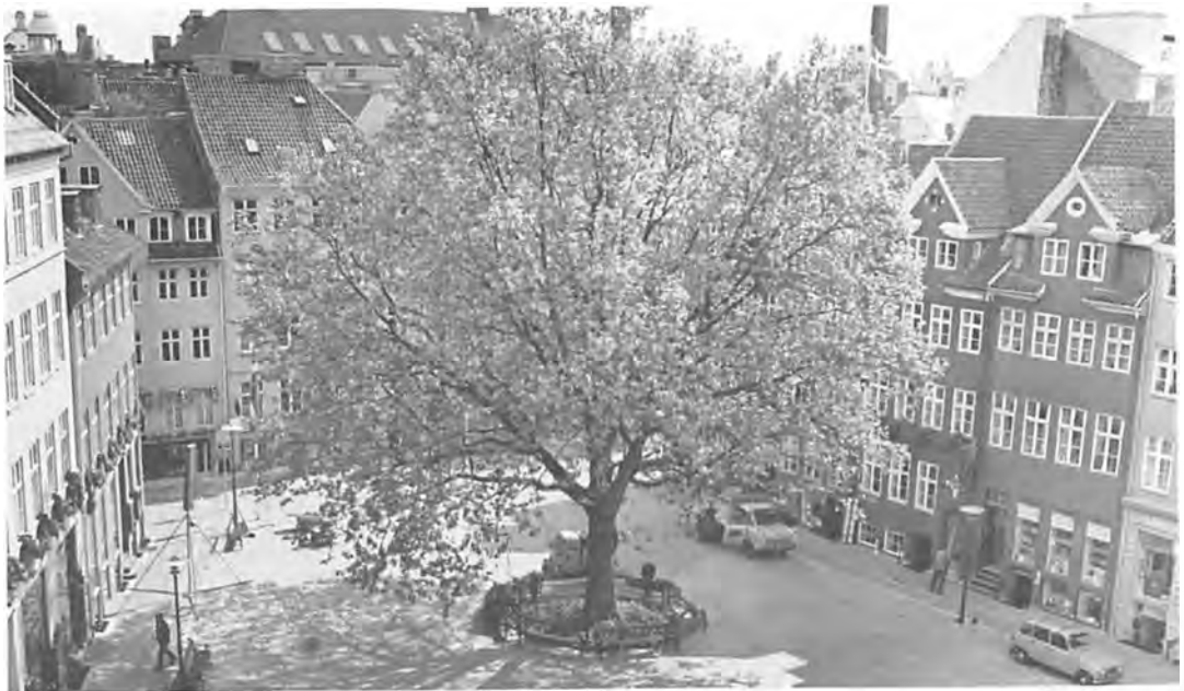
Fotografi fra »vore dages« helt brolagte torv med det gamle træ fremdeles i pladsens centrum. Torvet har fået sine rigtige dimensioner igen. Foto fra 1972. – Nordfoto.
