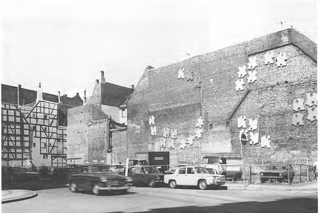
Man måtte have troet, at det er noget meget vigtigt, der skulle bygges her, men endnu i 1987 udgør tidligere Lille Regnegade, nu Ny Østergades sidste fase, et nyt bombekrater til glæde for bilister, der skal parkere. – Fot. 1976. Stadsingeniørens Arkiv.
