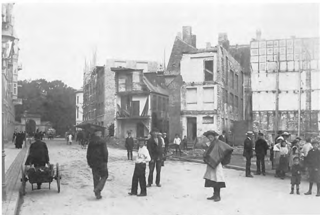
Samme motiv et halvt år efter. Den store trekant på venstre side af den skrå Christian IX's Gade er færdig. Gaden er næsten færdiganlagt, men man er ikke klar endnu med nedrivningen af højre side. Fot. 1908. – Bymuseet.
