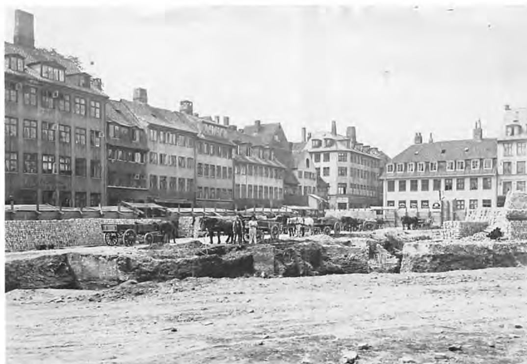
Her er den vestre del af byggepladsen set fra Store Regnegade med Gammel Mønt 31-41 til venstre. Den sidstnævnte er den eneste karré i dette kvarter, der er bevaret i vore dage (se side 116). Til højre Møntergade 19-21, samt Vognmagergades udmunding. Fot. Elfelt 1907. – Bymuseet.
