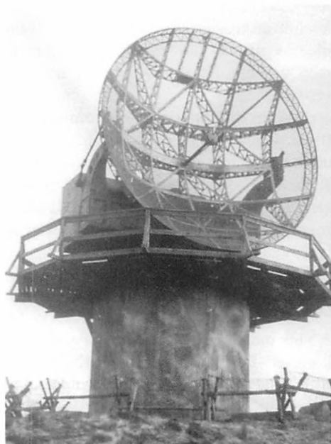
Hanstholm: »Würzburg Riese«-radar på lavt beton-tårn.
