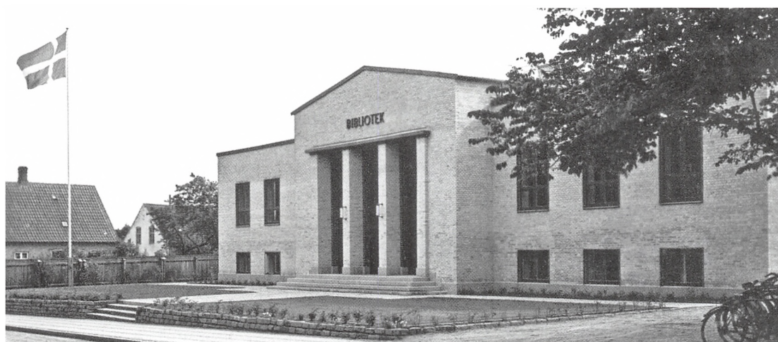
Thisted Bibliotek umiddelbart efter opførelsen i 1938.
