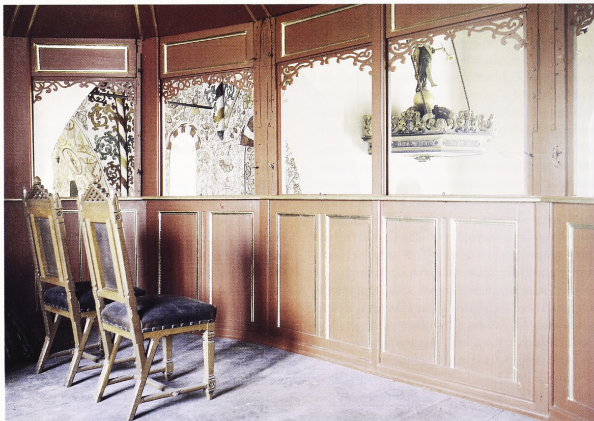
Fig. 15. Schackenborgs stol, kaldet Grevindestolen, er opsat sammen med nordpulpituret 1692. Den har gennemgået en grundig snedkermæssig istandsættelse og står nu udvendig med den grå marmorering fra o. 1740. Af økonomiske grunde afstod man fra at afdække den dertil hørende røde zinnober i det indre. Den røde farve er i stedet nymalet, ligesom profilerne er nyforgylt. De murede bagvægge mod nord og øst har en lysegrå flisebeklædning, som er blevet rensset for brun maling fra 1898 og suppleret med nye fliser i fornødent omfang. Til Grevindestolens istandsættelse har Dansk Paramenthandel skænket et beløb.
