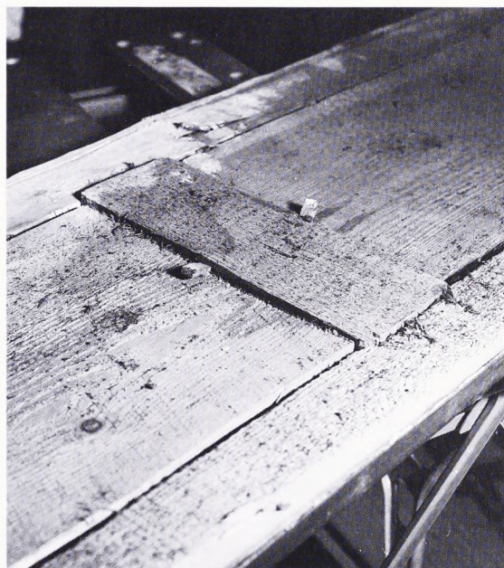
Fig. 3. Fyldingerne er ikke som normalt monteret i én ret hele vejen rundt. De er lagt i en fals og sikret med et, efter forholdene, ret lille antal kileformede pløkker, der er drevet ind i rammestykkerne. Dette kan måske være en af årsagerne til, at mange af fyldingerne er sprunget fra i siderne. Foto Søren Møller.
