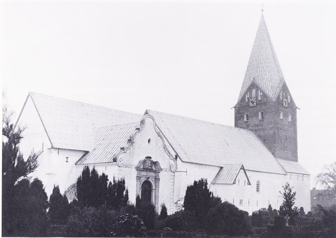
Fig. 1. Møgeltønder kirke set fra nordøst efter restaureringen. Der ligger nu bly på alle tage, ligesom den tidligere cementafdækning på det grevelige gravkapels gavl er erstattet af bly.
