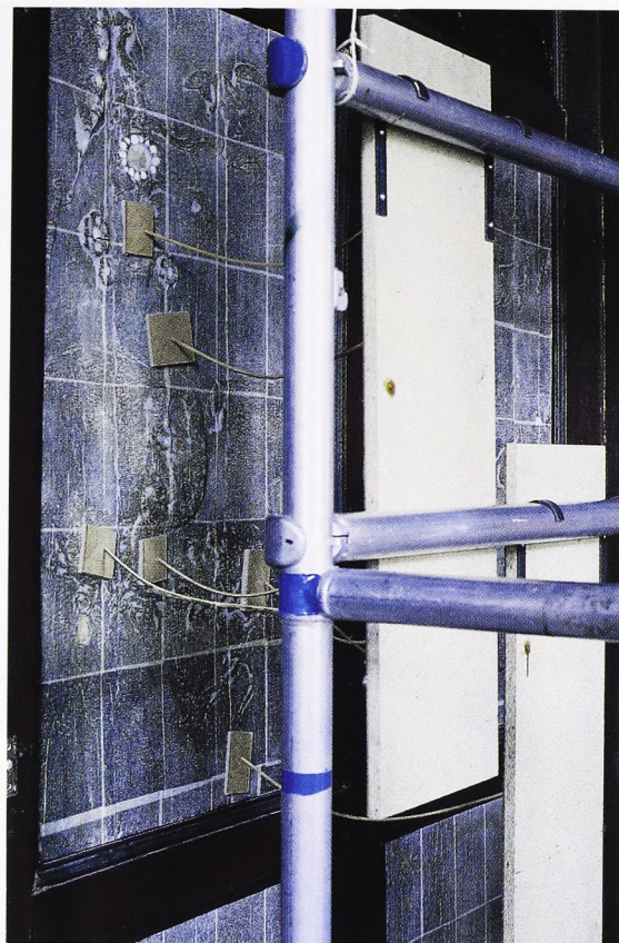
Fig. 5. Fastlægningsprocessen. Varm hudlim blev sprøjet ind under farvelaget, og optørringen foregik under pres et døgn. Her ses, hvorledes trykklodserne, beklædt med beskyttende skungummi, holdes under pres af bambuspinde i spænd mellem væg og stativ. Foto Søren Møller.
