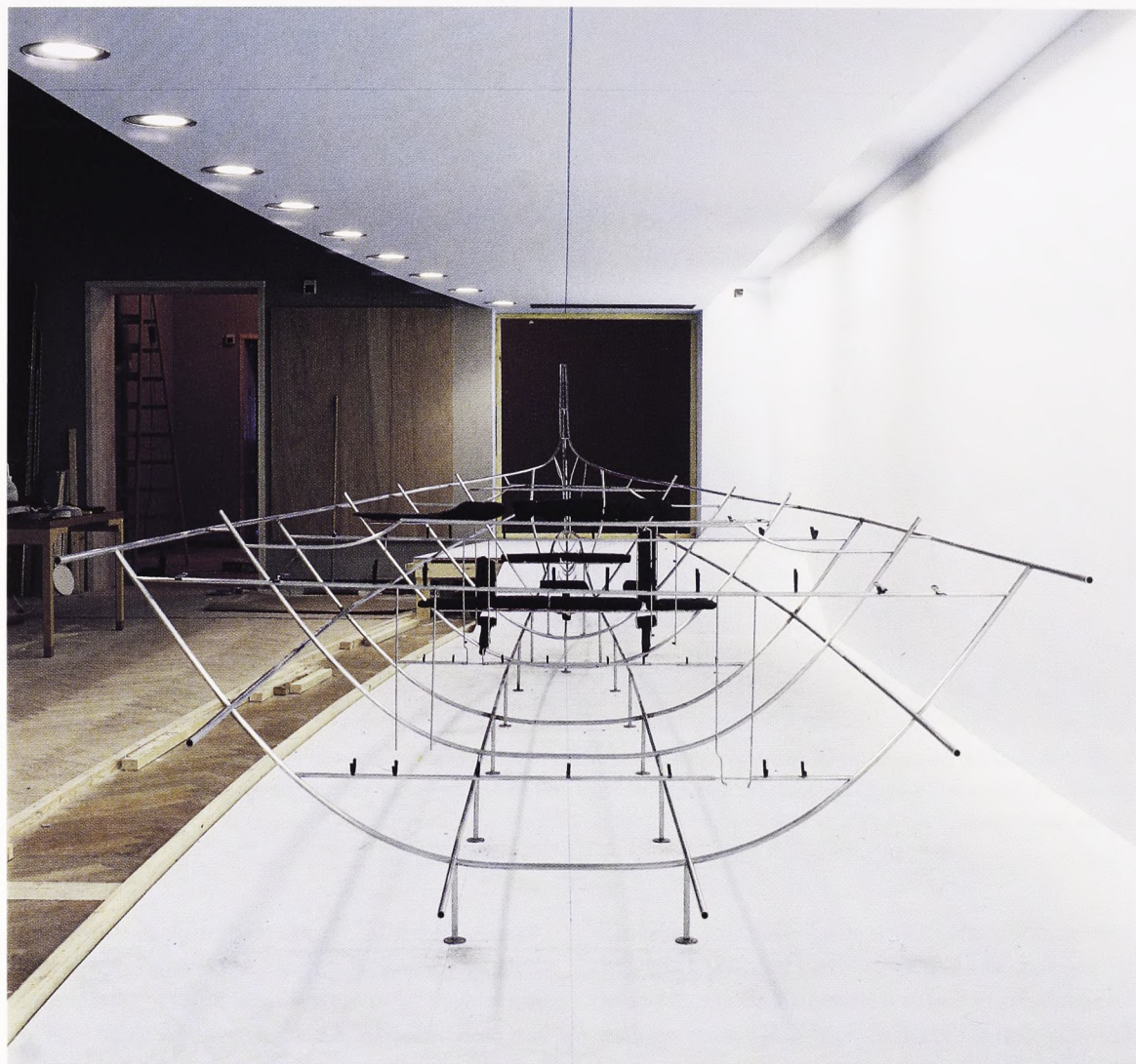
Fig. 8. Hjortspringbådens stålskelet under opbygning. Skelettet blev fremstillet i sektioner, som en efter en blev bragt på plads i montren og sammenføjet ved slaglodning. Med ganske enkle virkemidler blev skelettet gjort næsten selv bærende, så understøtninger, der kunne være generende for helhedsindtrykket, blev undgået. Foto John Lee.
