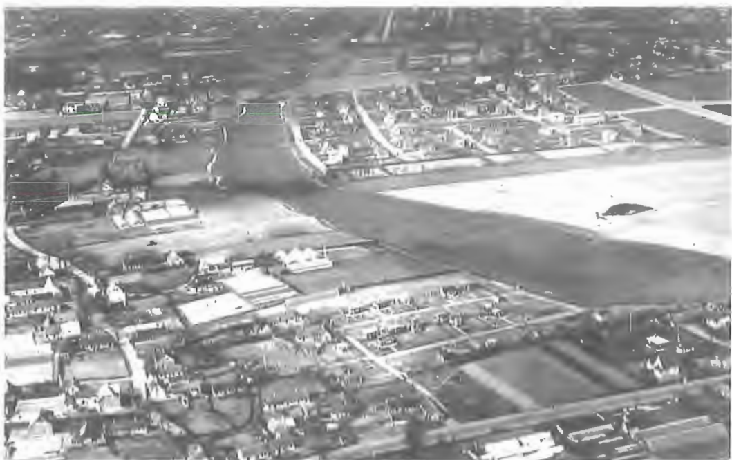
Der er parceller, gårde og gartnerier og mas- ser af åbent land. Luftfoto 1935 - det er Hvidovregade tv i for- grunden. (Foto HLA)
