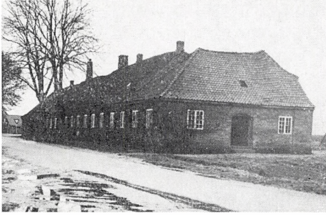
Arbejderhus ved Kærstrup fotograferet umiddelbart før dets nedrivning i april 1977. I vestenden af det lange rødstenshus boede forvalteren med familie, og resten af huset var opdelt i værelser til ca. 18 arbejdere, der havde fælles køkken og baderum.
