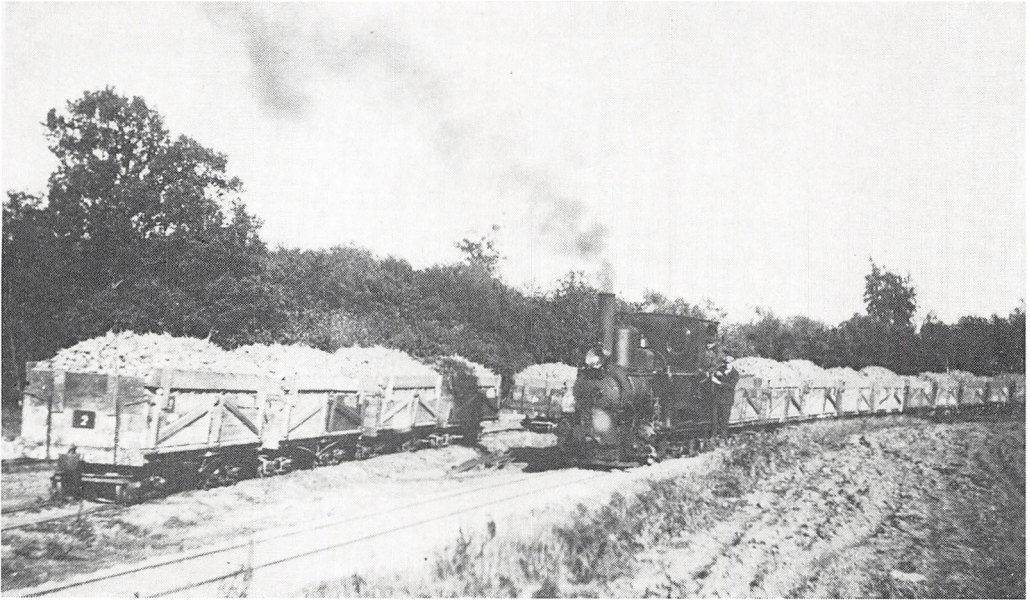
Roetog fotograferet ved Søholt. Transporten fra dyrkningsstedet til fabrikken blev løst ved hjælp af de smalsporede roebaner. Allerede i 1874 blev de første spor lagt, og vognene blev trukket af heste. I 1894 gik man over til lokomotiver som trækraft, og banen blev udvidet til Errindlev,
