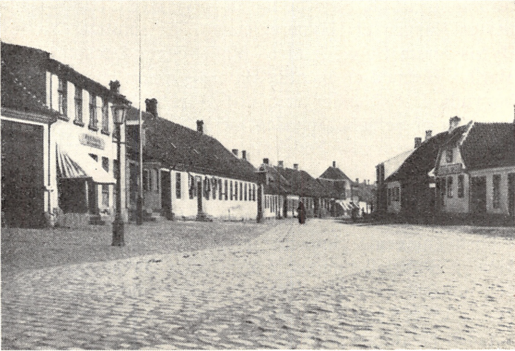
Saxkjøbing. Søndergade set fra Torvet ca. 1900.
