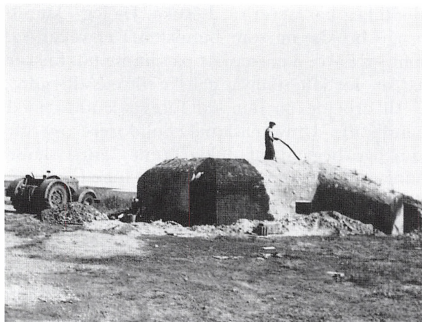
Midt i hver rum i Bunkeren var anbragt en afmålt ladning Trotyl. Efter at alle huller var tætnede, blev bunkeren fyldt med vand
