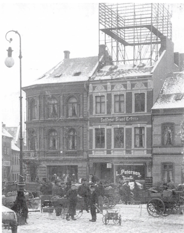
Axeltorv 4 med telefoncentralen. Foto: Bech
