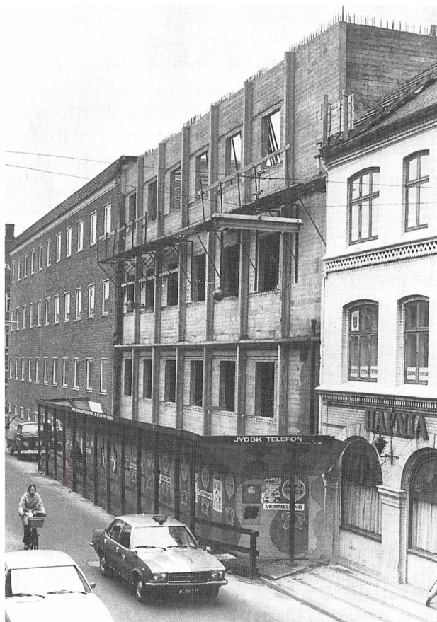
Byggefase 3, foto fra ca. 1970
