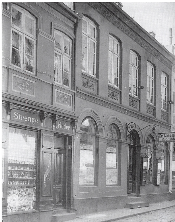
Låsbygade 23-25. Husene har pudsede facader med hovedgesimser og formstensfriser, og under vinduerne er der henholdsvis malede og plastiske dekorationsfelter.
