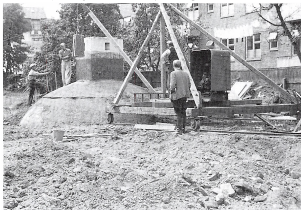
Før nedbrydning af bunker i Sydbanegade
