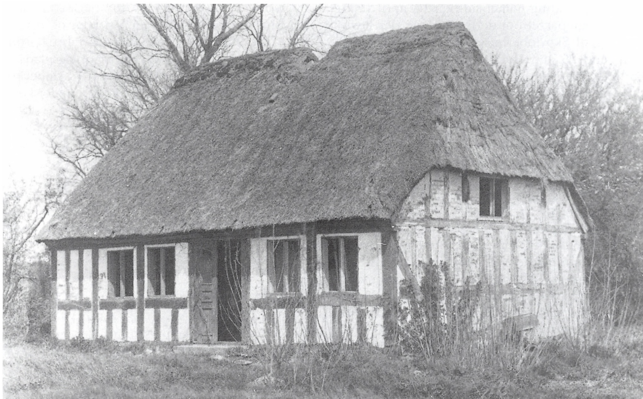
Huset i Starup under nedbrydning
