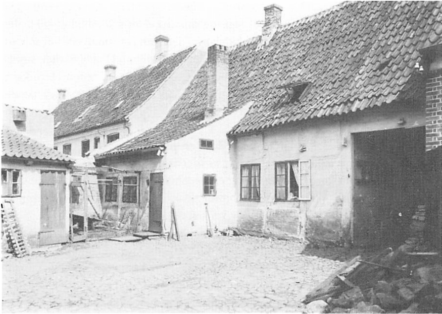
Bagsiden af forhuset i Algade 110B, Nationalmuseets 2. afdeling, Hugo Matthiessen 1913. Bemærk den lille 3-fags udbygning med egen skorsten. Sådanne bygninger (luder) var almindelige i danske købstæder i 1700-tallet, og her befandt køkkenet og bryggeret sig sædvanligvis.
