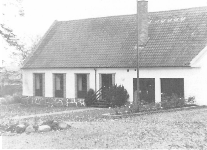
Fig. 29. Ladens facade mod kirken efter ombygningen i 1972. (Foto. forf.).
