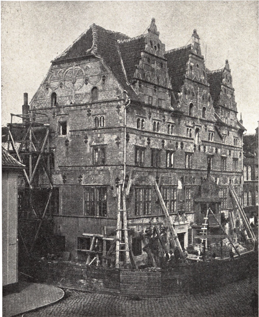
Svaneapoteket under Ombygningen.
