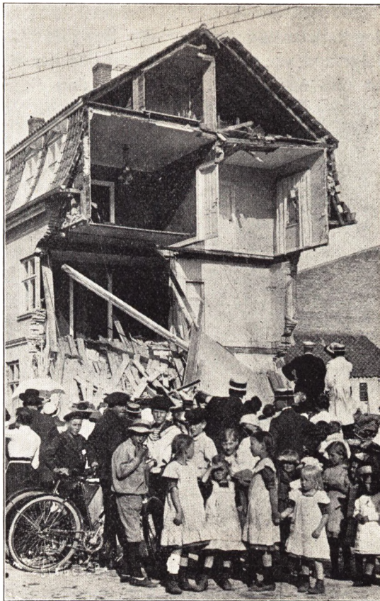
Et mærkeligt Uheld overgik den nye Ejendom paa Bredegade 13 (Matr. Nr. 13) 15. Juni 1915. Det halve af Huset styrtede sammen; ingen Mennesker kom noget til.
