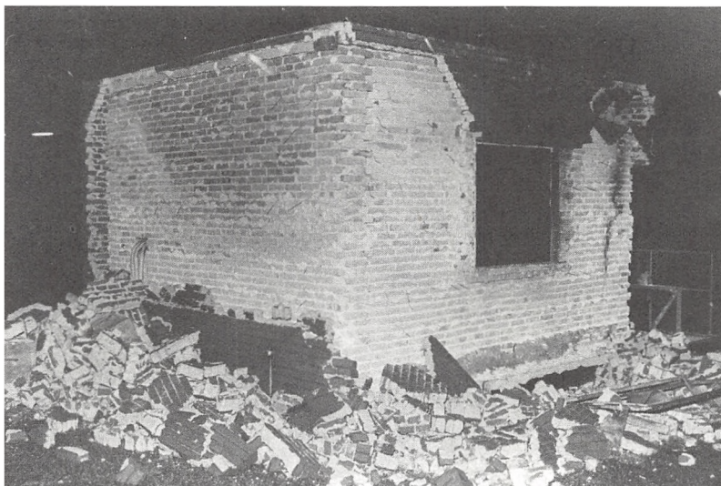
Sådan så Vejlbj-Risskov rensningsanlægs pumpestation på Lystrupvej ud, efter at den d. 11. december var blevet raseret ved en voldsom eksplosion, der hørtes over det meste af byen. (Foto: Jens-Kristian Søgård)
