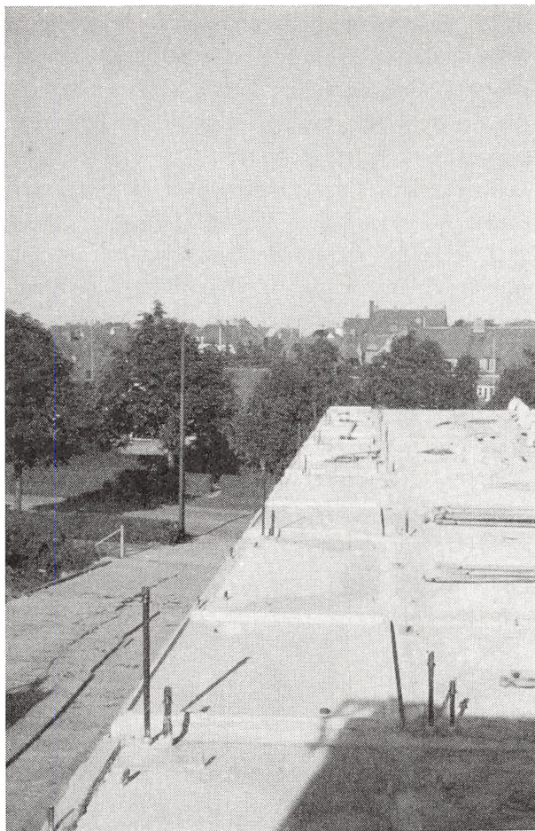
Fig. 15. Hareskovvej. Rørarbejderne følger nøje montagerytmen.
