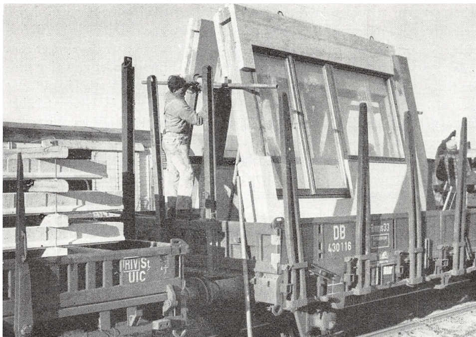
Fig. 3. Eksport: Betonelementer til Hamburg (Larsen & Nielsen Constructor A/S).
