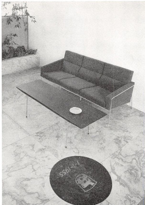
Gulvbelægning i Rødovre rådhus, udført af sleben Gjellebæk marmor. Dækstenen i gulvet er af finsleben Solvaag sten med indlæg af rustfrit stål. Arkitekt: Professor Arne Jacobsen, m.a.a.
