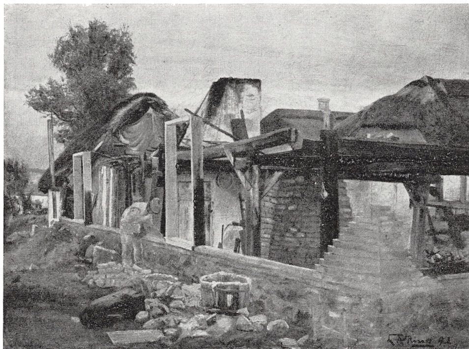
L. A. Ring, mureren arbejder på ombygningen af en sjællandsk gård. 1892.
