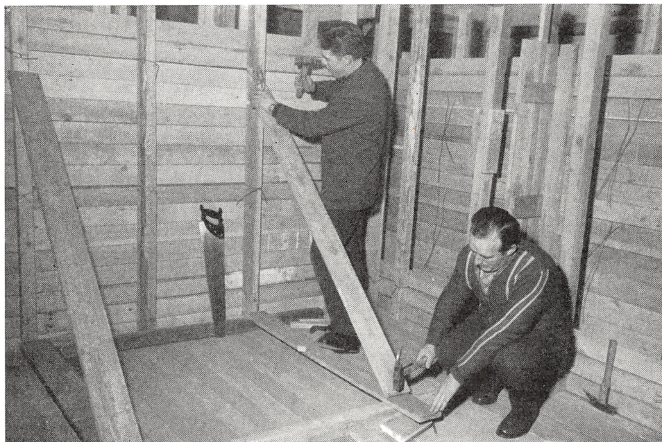
Fig. 1. Forskallingsøvelser.
