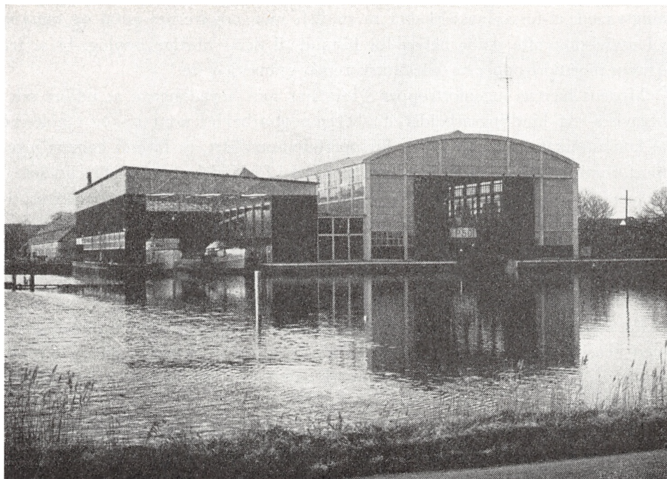
Fig. 9. Orlogsværftet. Reparations- og skibsbygningshal samt udrustningshal.
