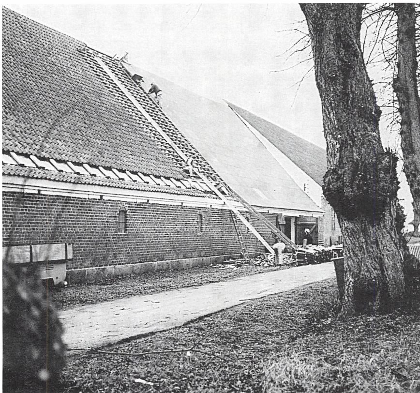
Fig. 28. Tegltaget på bygn. 3 udskiftes med eternit 1971. Til venstre ses den stribe tagvinduer, der blev indsat ved genopbygningen efter branden 1950.
