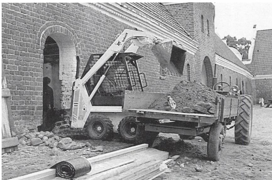
Fig. 32. Ved istandsættelsen af bygn. 4 blev gulvet sænket, og p.g.a. den smalle dør måtte der bruges en mini-gravemaskine.
