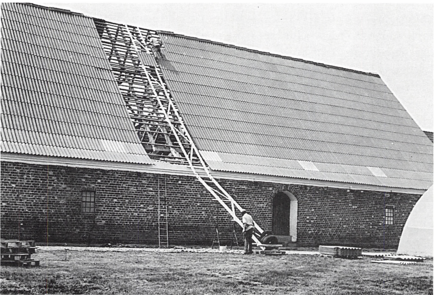
Fig. 30. Ved restaureringen af bygn. 3 blev de 5 år gamle eternitplader taget ned med forsigtighed, da de kunne sælges.
