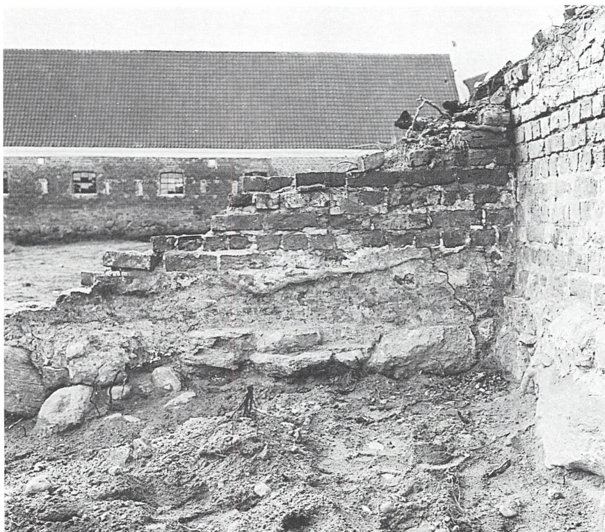
Fig. 37. Parti af den frilagte ruin af kostalden (nordfløjen), som brændte 1948. Kostaldens sydmur er ikke i forbandt med vestfløjen og må derfor være yngre end denne. På murens inderside ses tydelige brandspor, der må stamme fra en brand i 1874, eftersom gulvniveauet ved branden i 1948 var ca. 125 cm højere.
