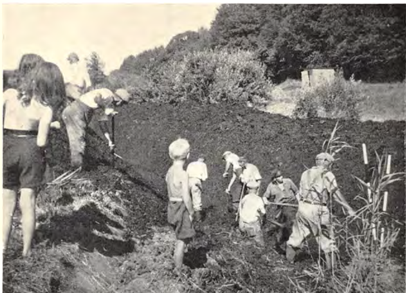
Uddybningsarbejde i Elbodalen.
