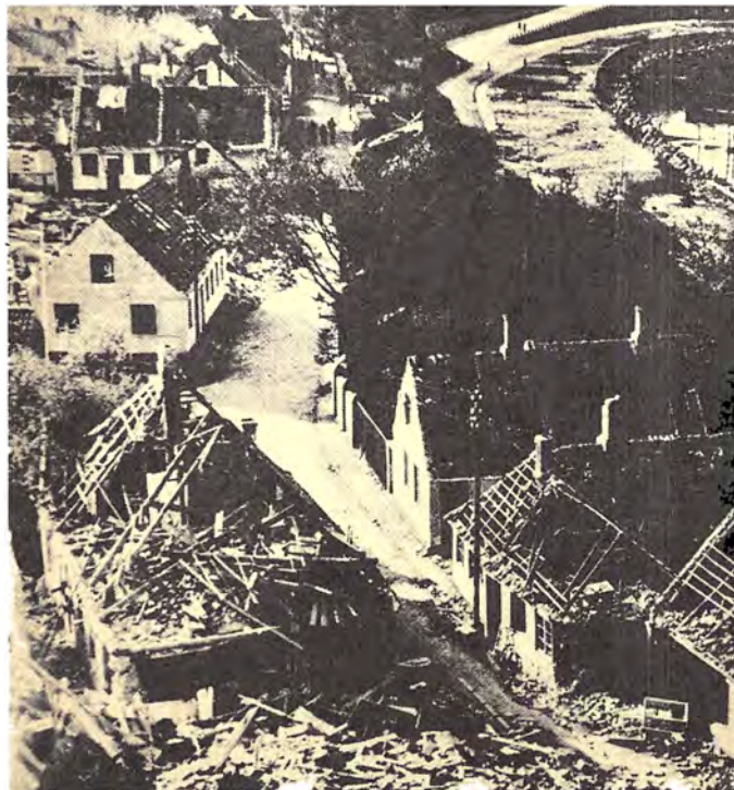
Ruiner i Rønne efter det tredje russiske angreb
