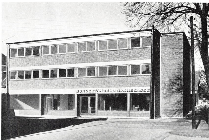
Fakse kontor. Bygningen opført i 1958-59
