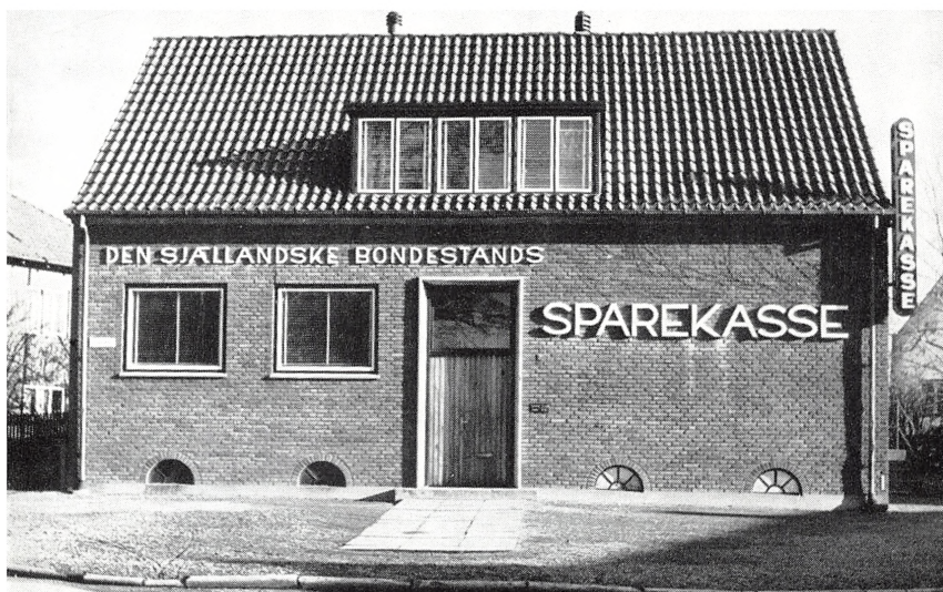
Dianalund kontor. Bygningen opført i 1942
