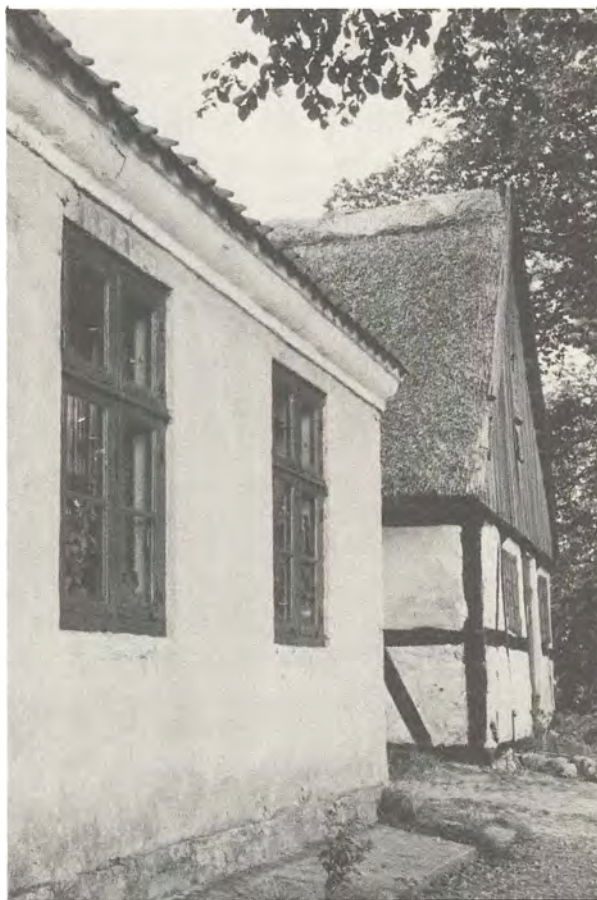
Rytterskolen i Sonnerup, Højby sogn i Nordvest-Sjælland, opført 1735 med tilhørende udhus i bindingsværk. Skoleholderen øgede sin kummerlige indtægt ved at brænde brændevin og holde smugkro for bønderne. – Frilandsmuseet fot.
