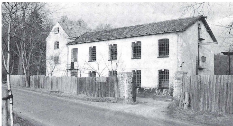
Senere gav Christian Nielsen bygningerne et mere harmonisk ydre, som de bevarede til 1972. På grund af eksplosionsfaren var lamperne monteret udvendigt og lyste ind gennem vinduerne. Privateje
