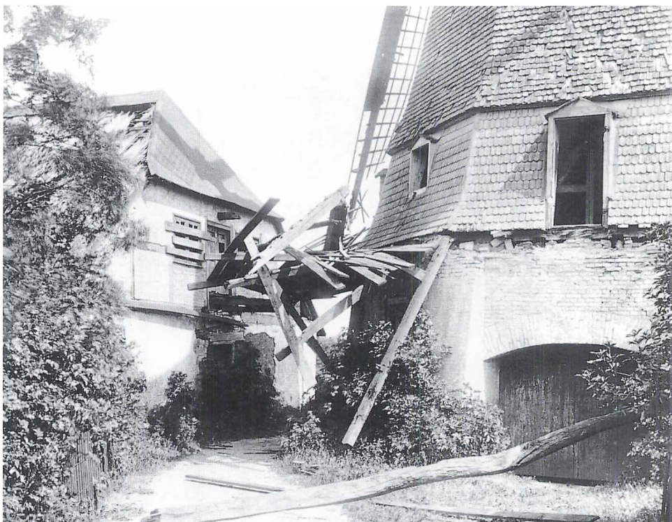
Fuglevad vindmølle i forfald. Midt i billedet de sørgelige rester af broen mellem magasinbygningens kornloft og mølleomgangen, der i øvrigt er faldet ned. Ukendt fotograf, udateret. Frilandsmuseet
