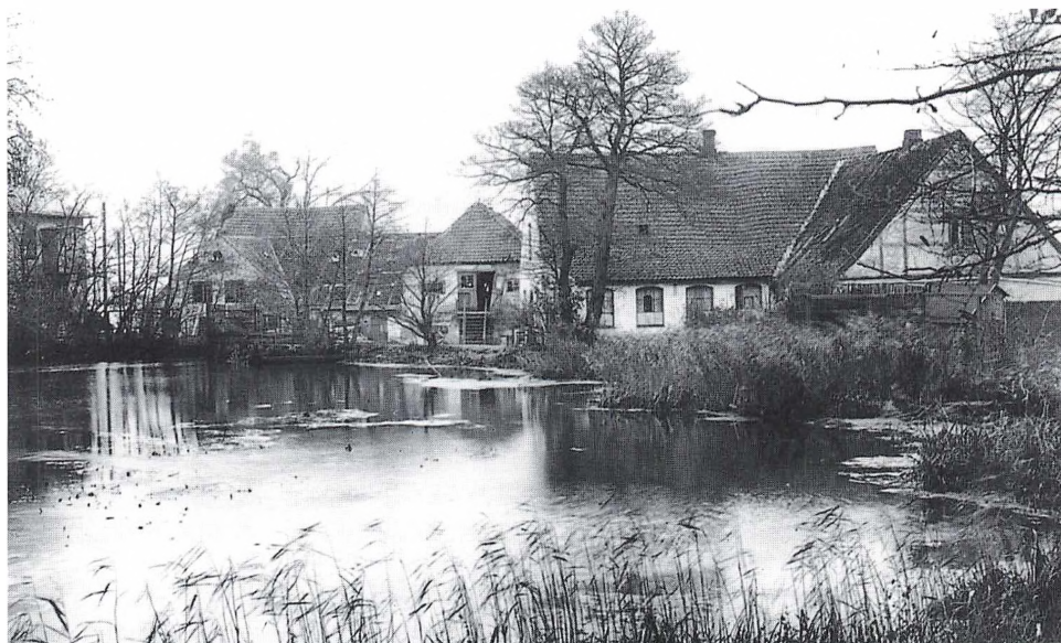
Øverst det i teksten omtalte hus, hvor Christian Nielsen boede i 1917-18. Nederst det samme hus set fra mølledammen med de gamle møllebygninger i baggrunden. A/S Strandmøllen Industrigas
