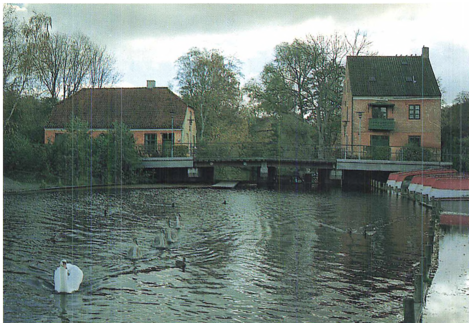
Frederiksdal mølle i 1998. Det høje hus til højre er resten af et større hus i samme højde, der har ligget hen over åens gennemløb med indvendigt vandhjul, jfr. tegningen s. 15 nederst. Nedrivningen skete i 1887, for at vandet uhindret kunne løbe fra Furesøen gennem Fæstningskanalen i tilfælde af krig.
