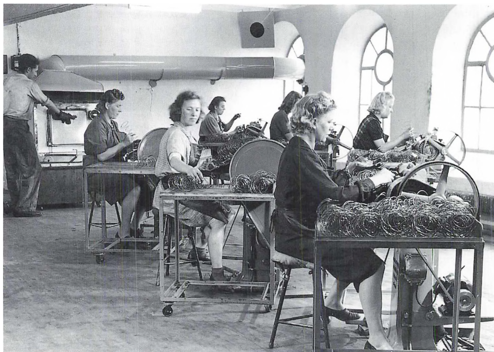
Scene fra arbejdslivet på »Lama« på Ørholm i slutningen af 1940'rne. Kvinderne laver fjedre til springmadrasser. Den elektriske kraftoverførsel med enkelt drift er gennemført, og arbejdsmaskinernes placering i lokalet er uafhængig af faste installationer bortset fra el-stik. Byhistorisk Samling
