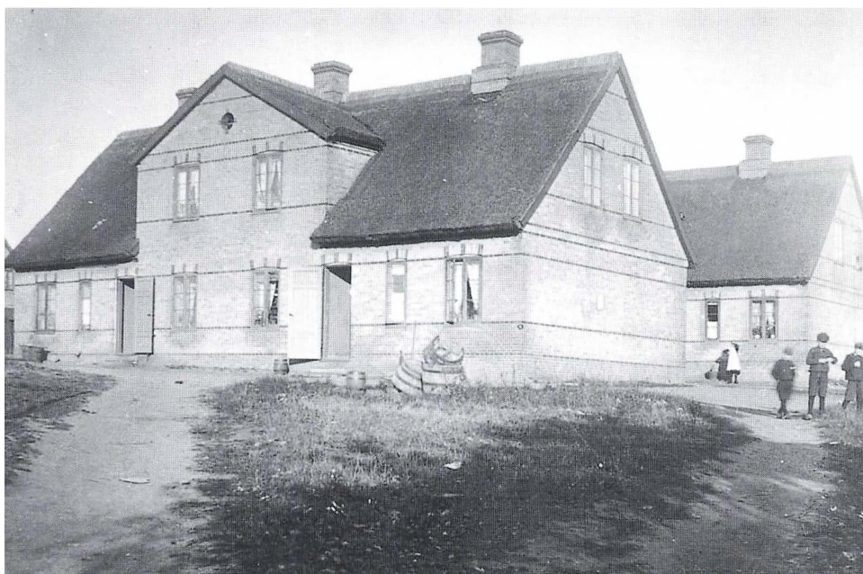
»Boston« i 1905, med »Wien« t.v. og »New York« t.h. Dørene på denne side fører ind til en lille entré med adgang til alle husets fire lejligheder. De små vinduer sidder i yderlejlighedernes køkkener. Fra Edmund Daverkosens jubileumsalbum.
