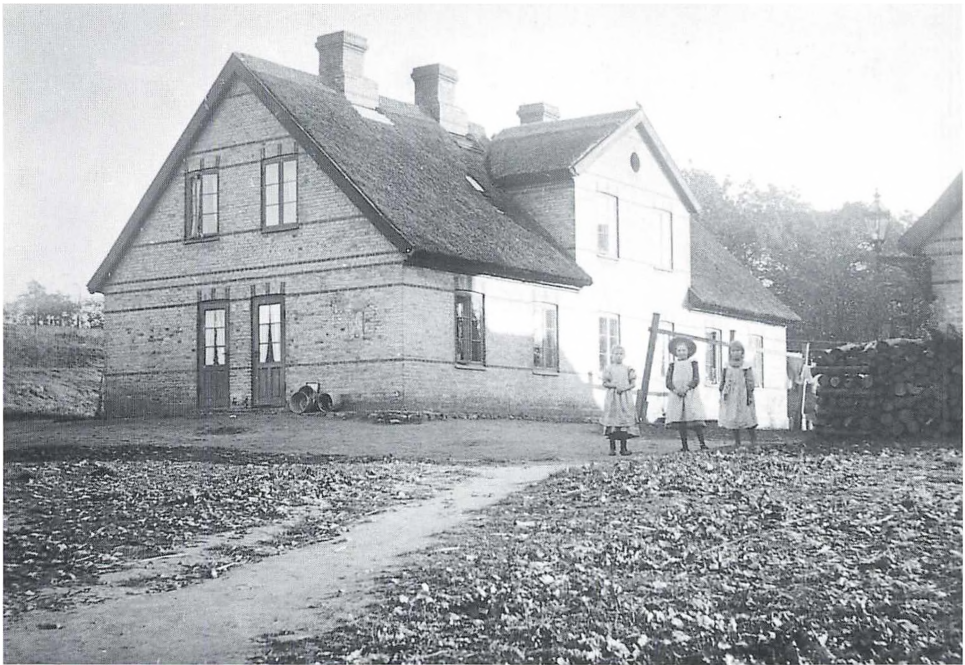
»Paris« i 1905, set fra nordvest. »Paris« var anderledes disponeret end de øvrige Gule Huse. Stueetagen rummede 5 étværelses og 2 tovværelses lejligheder. De 4 étværelses lejligheder havde indgang fra gavlene med døre direkte ind i køkkenerne. Døren til den femte anes bag ved pigen i midten. Tovværelses lejlighederne havde indgang fra østsiden. Fra Edmund Daverkosens jubilæumsalbum.
