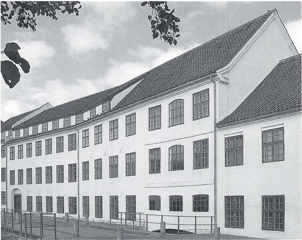
Parti af de hvide bygninger langs mølledammen. De 7 fag længst til venstre er bygning 2b fra 1832. De næste 4 fag er den opindelige sydgavl af bygning 2c ligeledes fra 1832. De følgende 3 fag er bygning 2e »Strømhuset« fra 1869, opført hen over åløbet. Til højre ses to fag af bygning 3a fra 1866. Rammerne om de fladbuede vinduesfag i »Strømhuset« er af jern, resten er traditionelle trærammer. Forf. fot. 1999.
