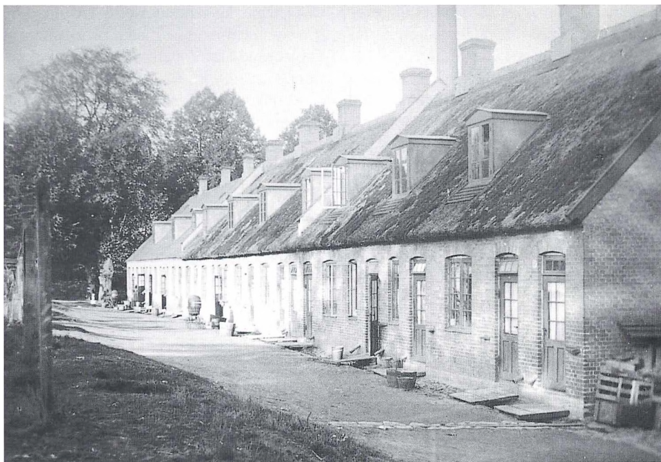
Den Lange Længe i 1905, set fra sydvest. Bygningen er bevaret, og den nordlige trediedel har stadig skifertag; men stråtaget på resten af bygningen blev i 1941 udskiftet med tegl. Billedet viser, at køkkenvaskerne havde afløbsrør ud gennem muren til den åbne rendesten langs huset, hvorover der var lagt løse gangbroer ved dørene. Fra Edmund Daverkosens jubilæumsalbum, nu i Nationalmuseet.
