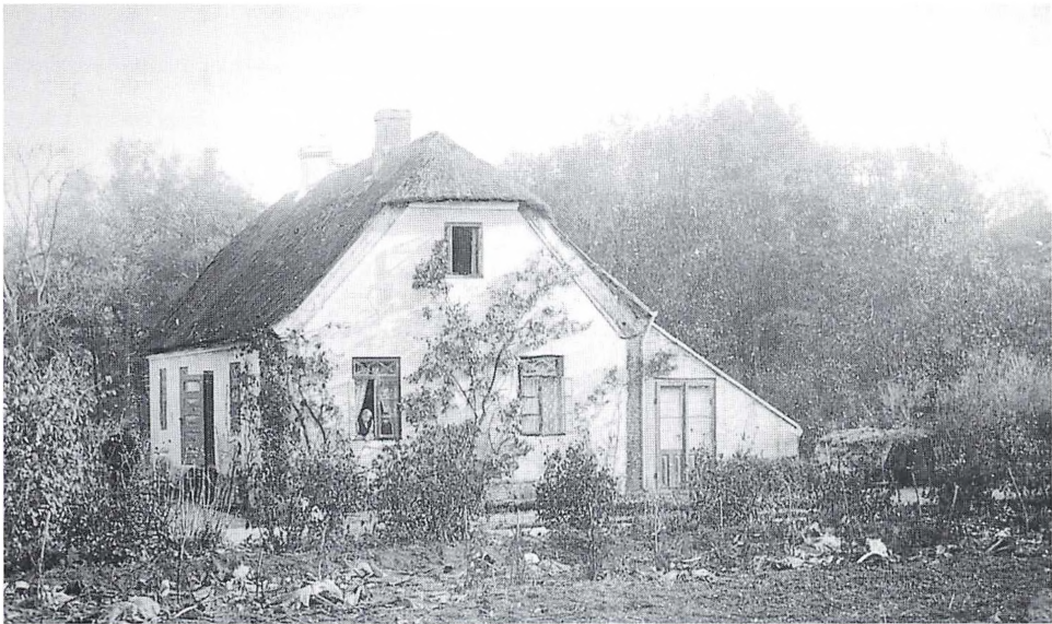
Gartnerboligen på Brede i 1905, set fra vest med drivhuset på den lune sydside. Gartneriet leverede dels til fabrikantens husholdning, dels til salg til arbejderne. Fra Edmund Daverkosens jubilæumsalbum.
