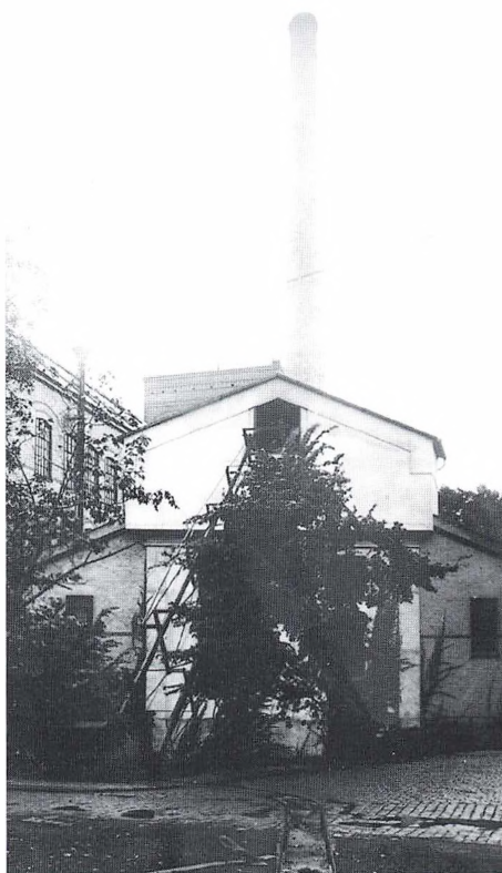
Det nye kedelhus med skorsten fra 1930. Fotografiet er taget fra samme sted som det forrige, men drejet lidt mod højre (nord), således at væveribygningen fra 1890/1894 nu ses til venstre. Et tipvognspor fører fra kulbunkerne ved Nærumbanen hen til kedelhusets fod, hvorfra en transportør bringer kullene op til lugen i toppen af gavlen og styrter dem ned i fyrene.
