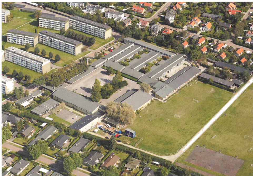
Fuglsanggårdsskolen i september 2009, set fra sydvest. De to bygninger i vinkel længst til højre er indskolingshuset fra 2001 og SFO (yderst). Til venstre for byggepladsen nederst i midten af billedet ses Heldags-skolens nye bygning under færdiggørelse. Aerodan Luftfoto. Lyngby-Taarbæk Stadsarkiv
