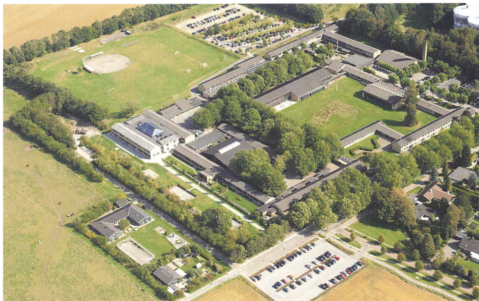
Trongsøskolen i september 2009, set fra sydvest. Af det store bygningskompleks udgør Trongsøskolen kun den vestlige tredjedel. Resten er det tidligere Jonstrup Seminarium, som efter lukningen i 1990 blev overtaget af Lyngby Handelsskole, senere Handelsskolen København Nord. Til venstre midt i billedet ses det nye indskolingshus (med SFO) fra 2005. Den brede bygning med ovenlysvindue midt i skolen er skoletorvet, der opstod i 2000 ved overdækning af den hidtidige vandhave. Aerodan Luftfoto.
