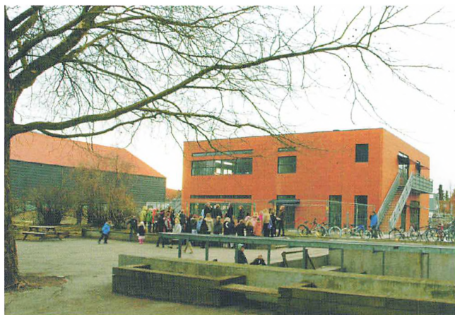
Hummeltofteskolens seneste tilbygning ved indvielsen i 2009. Den kvadratiske bygning indeholder en del af SFO ved Hummeltofteskolen og desuden nogle faglokaler. Jørgen Laursen foto.
