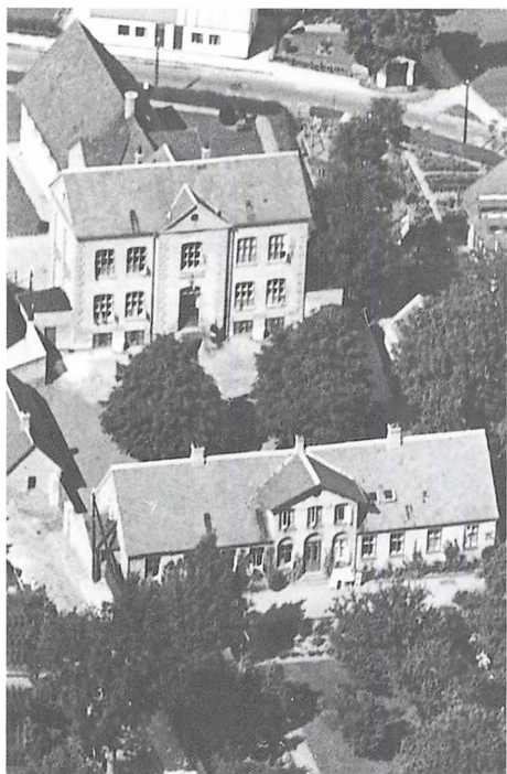
Lundtofte Gamle Skole set fra syd efter 1927. Forrest skolebygningen fra 1872, derover skolebygningen i to etager fra 1904 med gymnastiksalen fra 1927 tilbygget bagpå. Lyngby-Taarbæk Stadsarkiv
