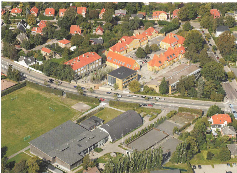
Engelsborgskolen i september 2009. Øverst de oprindelige bygninger fra 1908 og 1912-15 (østfløjen) samt mellembygningen fra 1930. Derunder langs Engelsborgvej fra venstre den tidligere hovedbygning fra 1935, den nye hovedbygning fra 2008 og fagklassefløjen fra 1977. Nederst ses Engelsborghallen fra 2001. Den halvrunde bygning er opført som tennis- og badmintonhal i 1936. Aerodan Lufifoto.
