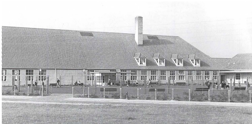
Den nyopførte Virum Statsskole i september 1958.
