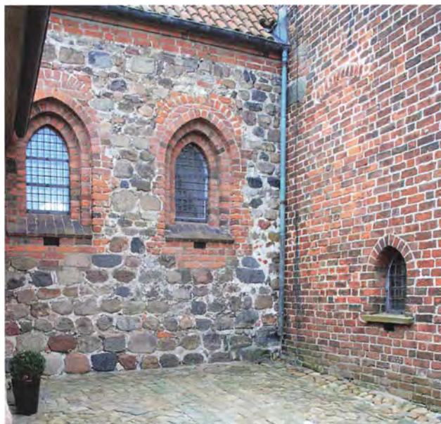
Kirkens nordvæg mellem sakristiet og tårnet stammer fra den oprindelige kirke. Det ses, at kampstenene er lagt i vandrette rækker (skifter), og at muren er forhøjet med tre skifter mursten. Over det højre af de to små vinduer ses spor af et ældre vindue, der har siddet højere i muren. Da man omkring 1500 byggede hvælvinger i kirken, har man måttet sænke og dublere vinduet for at få dem til at passe i midten af et hvælv. Til højre ser man spor af en dør i anden etage af tårnet. Før 1915 førte en udvendig trappe op til døren, hvor man gik gennem tårnet ind til et pulpitur over indgangsdøren mellem våbenhuset og kirken. Dette pulpitur kaldtes Taarbækstolen og var beregnet for den del af menigheden, der kom fra Taarbæk, før Taarbæk Kirke blev bygget i 1864. (forf. foto).
