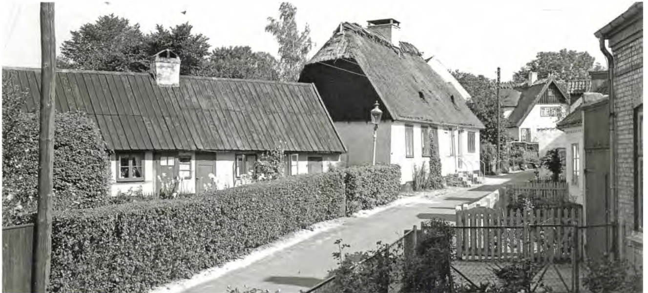
Tofamiliehuset Asylgade 11 har bevaret sin store gamle skorsten midt på taget, hvor der var aftræk fra ildstederne i to køkkener i midten af huset. Huset var oprindeligt indrettet med én lejlighed, men blev ombygget til tofamiliehus i begyndelsen af 1840'erne. Nabo huset Asylgade 13 med den skråt afskårne gavl er et meget bredt hus. Det blev i 1868 indrettet med fire lejligheder i halv dybde – altså en lejlighed i hvert hushjørne, med køkkenerne midt i huset og ildstederne med aftræk til en fælles, meget stor skorsten med fire kanaler (nu nedrevet). Udateret foto, antagelig fra 1940'erne. (Lyngby-Taarbæk Stadsarkiv).
