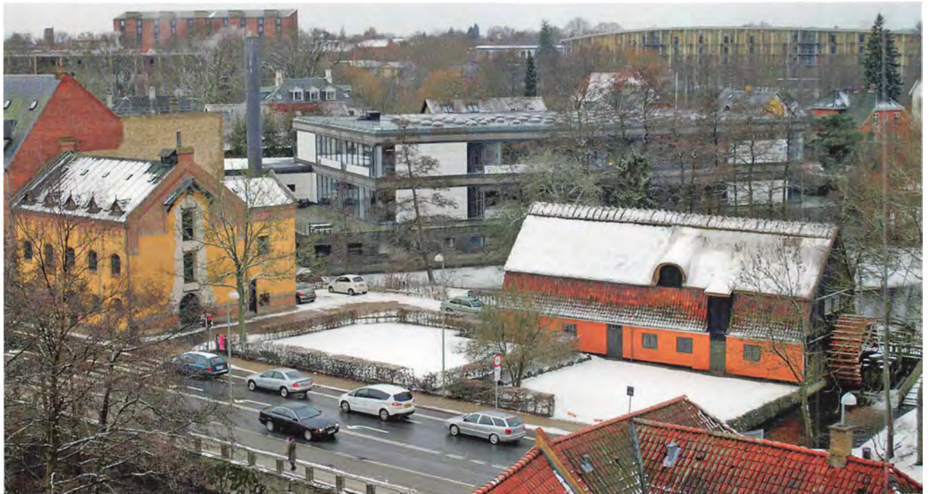
Lyngby Søndre Mølle fra 1903 (til venstre) og Nordre Mølle fra 1846/1850 med det udvendige vandhjul. Bagved ses Stadsbiblioteket. (forf. foto).
