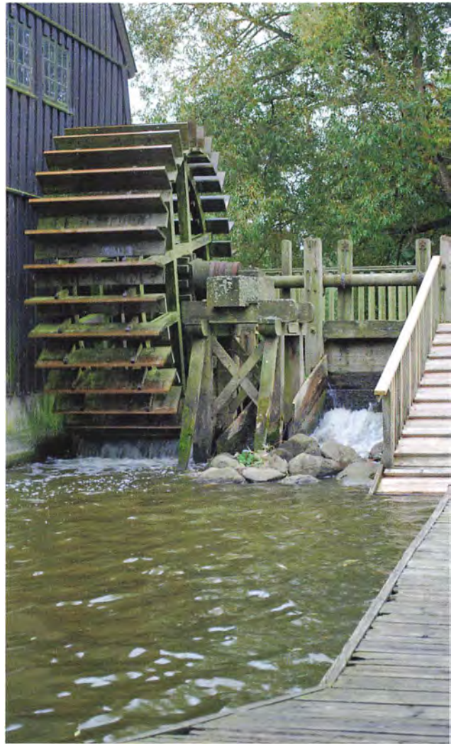
Vandhjulet på Nordre Mølle måler ca. fire meter i diameter og vejer omkring tre tons. På dets aksel sidder indvendigt i bygningen et tandhjul, som er forbundet med andre tandhjul i mølleværket. På billedet er vandhjulet i gang og lader vandet passere under hjulet med en portion vand for hver skovl. Til højre ses frislusen, der altid er åben og reguleres efter vandmængden i åen bl.a. for at undgå oversvømmelse efter kraftige regnskyl. (forf. foto).
