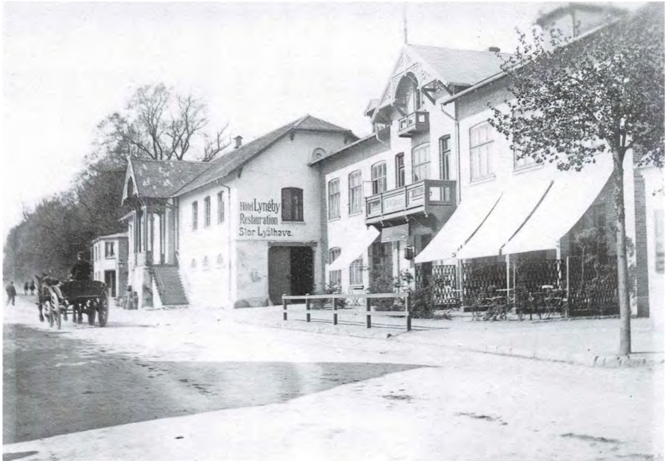
Hotel Lyngby omkring 1900. På hovedbygningen fra 1891 ses de oprindelige altaner og træskærerarbejdet på kvisten. Rejsestalden fra 1876 til venstre har port i gavlen og en markant dobbeltrappe på facaden ud til Lyngby Hovedgade. (Lyngby-Taarbæk Stadsarkiv).
