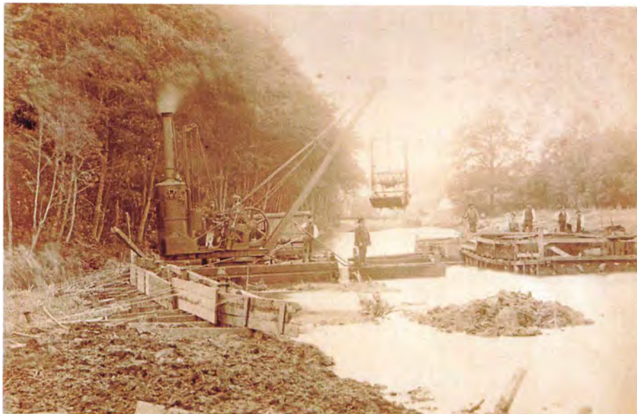
Fig. 6. Anlæggelse af Fæstningskanalen 1887-88 krævede omfattende gravearbejder, som her nær Frederiksdal Foto: Carl Sonne 1887, (Lyngby-Taarbæk Stadsarkiv).
