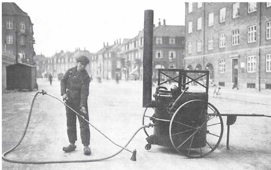
Emulsionsspreder, ca. 1940. Emulsionen i den lille kulfyrede beholder var en særlig asfaltsubstans der skulle få ny belægning til at »binde« ordentligt på den allerede eksisterende.
