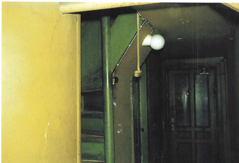
Bagtrappen med det lodrethængende tov, som vi skulle forcere, når vi skulle op til kontorerne i Banegårdsgade 39. Foto i privateje.
