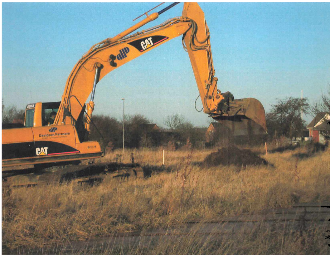
Første spadestik 12. december 2005, ikke højtideligt med flag og fint klædte mennesker, men blot en gravko, som til gengæld kan tage en ordentlig klump jord. Foto: Henrik Vedel-Smith.
