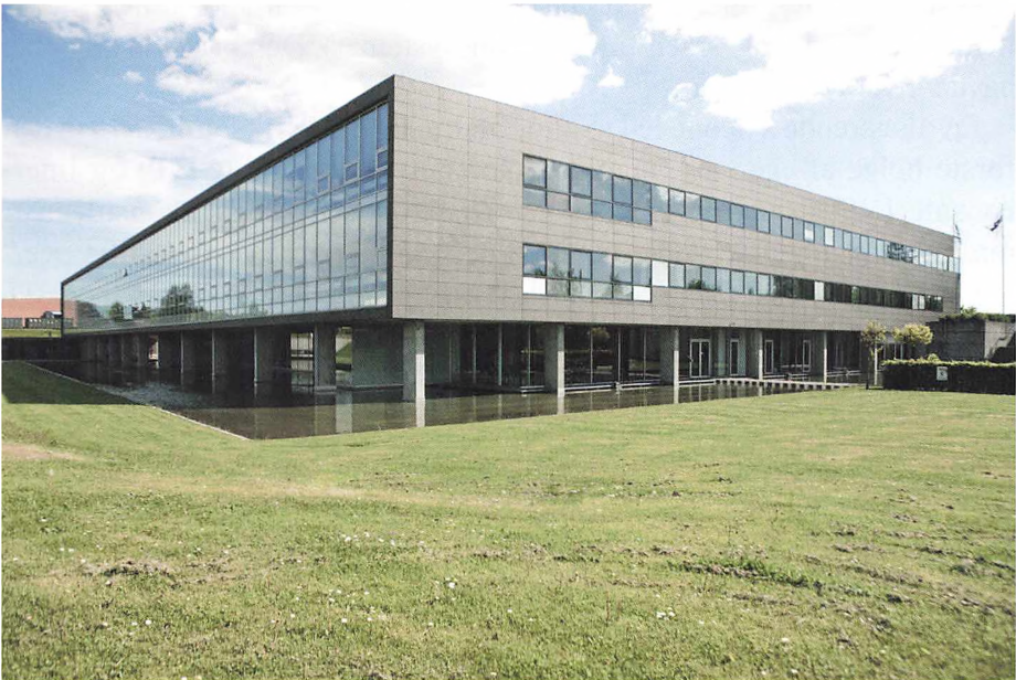
I 2001 opførte Stibo sit nye hovedsæde i Holme ved Århus. Bygningen er tegnet af det århusianske arkitektfirma Arkitema og er blevet præmieret. Den står som monument over to af de succeshistorier, som udgør en del af Århus bys erhvervshistorie. Foto: Stibo.
