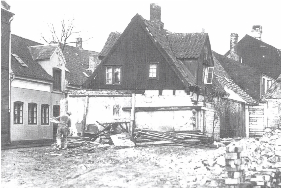
Nedrivningen i gang i Skolegadekvarteret.
