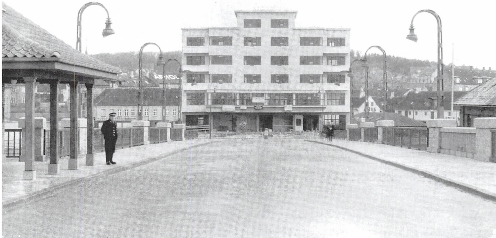
Brogården, tegnet af arkitekt Charles Jensen, under opførelse på Nørresundbysiden set fra broen. Brovægten står uden for brohuset til venstre og ser til.
