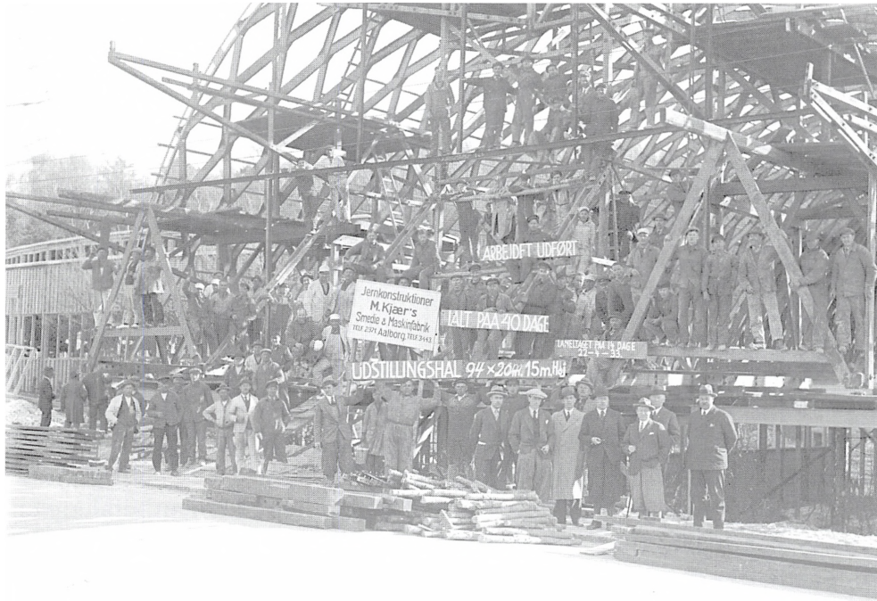
Fra konstruktionen af hovedhallen, der blev Danmarks næststørste lokale kun overgået af Forum i København. Odgård og Glahn står nr. tre og fire fra højre.
