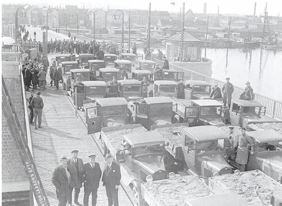
Belastningsprøve på Limfjordsbroen 22. marts 1933, der bestod af 48 lastbiler lastet med grus.
