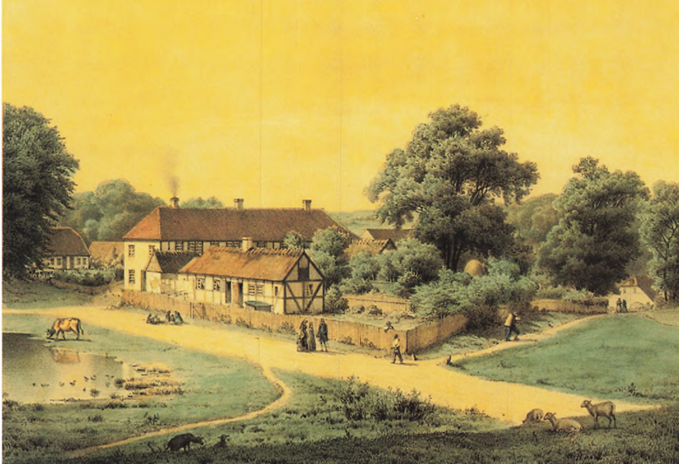
Raadvad 1830. I forgrunden ses den nu opfyldte Karussedam og en af værkets boliger, Karussehuset. Huset i 2 etager er Fileværket, der stammer fra 1700-tallet. Her havde smedemestrene værksted i stueetagen og bolig for familie og evt. logerende svende og drenge på første sal. Til højre for Fileværket skimtes taget på Raadvad Skole. I baggrunden til højre ses Hammerværket. Farvelagt litografi tegnet af Nordahl Grove og stukket af Kittendorff 1830. (Byhistorisk Samling for Lyngby-Taarbæk Kommune)
