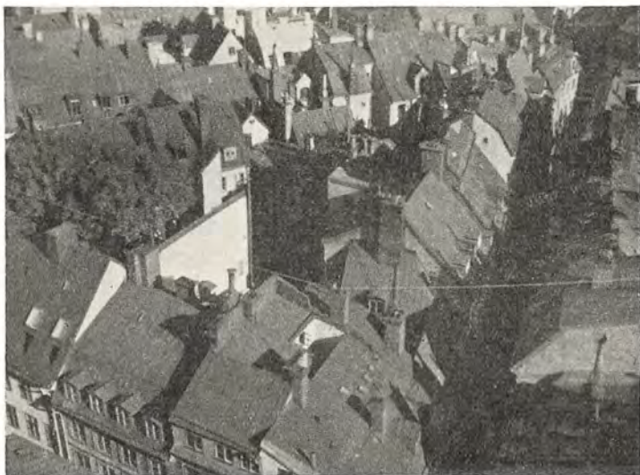
Karre'en Cepheus før Saneringen og Baghusenes Nedrivning.
