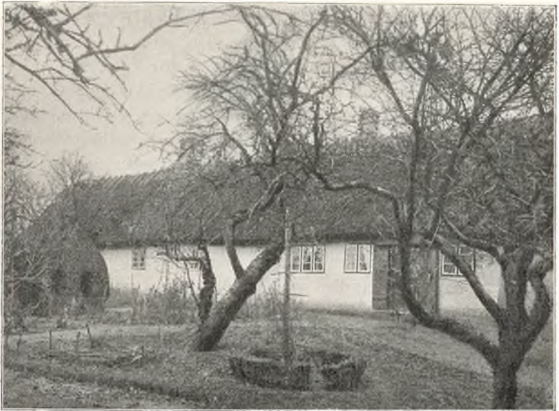
Stuehuset i Marie Christophersens Fødegaard, set fra Haven. Huset er bygget 1827; men der er ændret en Del ved Vinduer og Døre.
