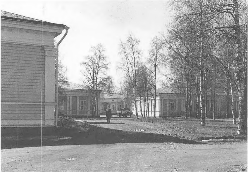
Bilden av skarpskyttebataljonens kasernområde i Uleåborg skulle lika väl kunnat vara tagen i Kuopio, St Michel, Åbo etc, ty de byggdes med lika ritningar. I början var blockhusen utan fodring som dock var nödvändig mot kyla och drag. (SA-foto)
