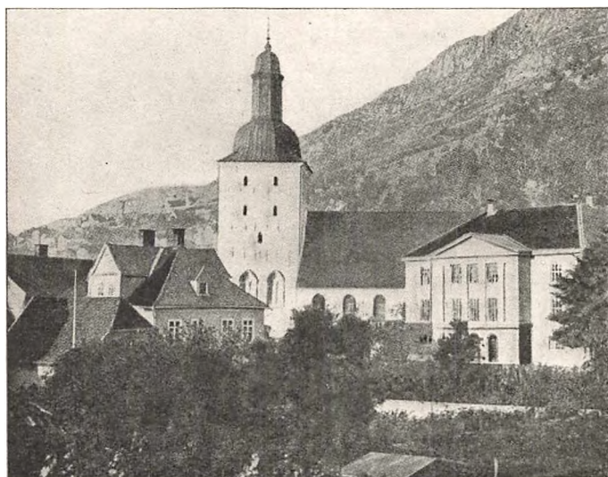
Bergens domkirke før restaureringen.
