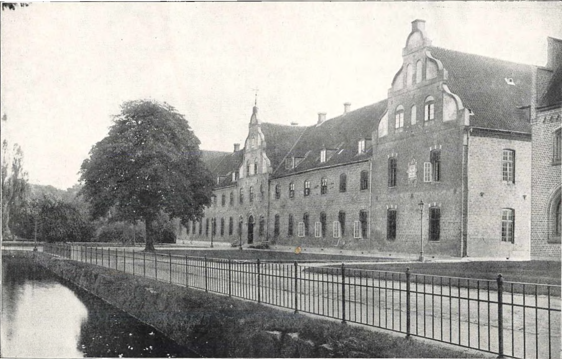
Skolebygningen set fra Godskontoret. Tilhøjre Gavlf af Musæumsbygningen, i Baggrunden Raadmandshavens Bøge.
