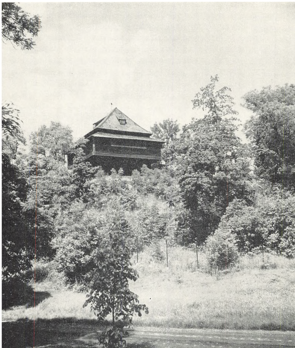
På herregården Björkvik i Östergötaland står dette loftshus med et stærkt udkragende øvre stokværk. Det er bygget som fadebur. (Iwar Anderson fot.).
