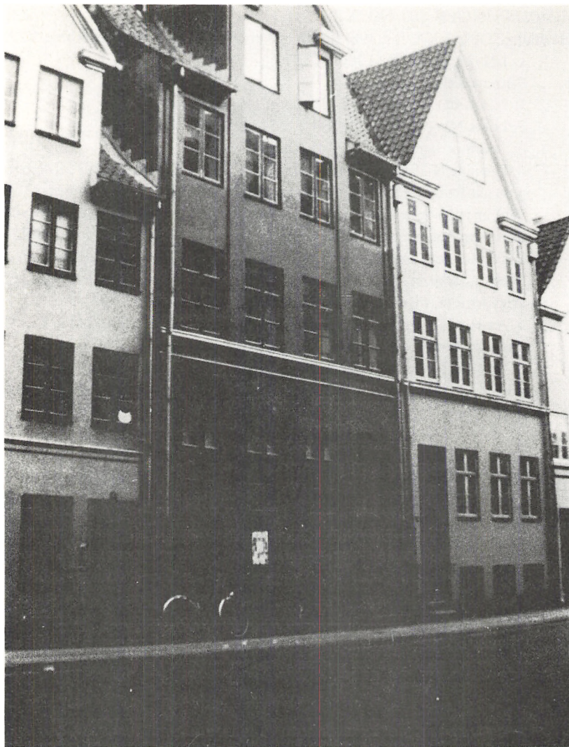
Landemærket 51 efter restaureringen i 1970'erne. Nr. 51 er huset t.h.
