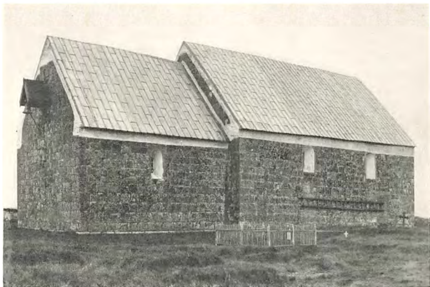
Hover kirke i Ringkøbing amt, karakteristisk romansk kvaderstenskirke med kor og skib og bjælkelofter. Norddøren er tilmuret. Klokkeren i korgavlen.
