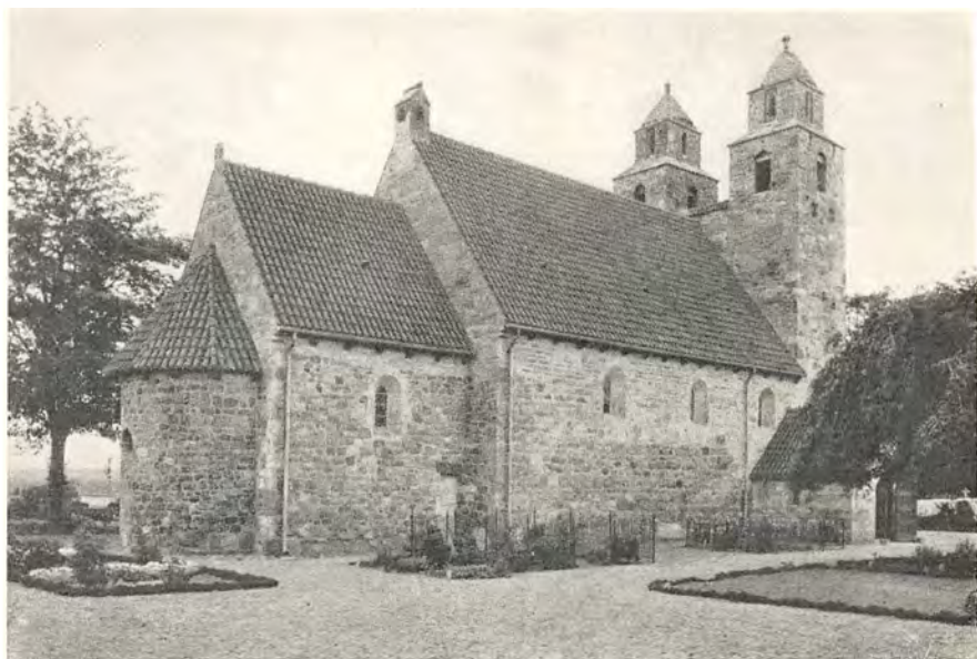
Tvoje Merløse kirkes tvillingtårne er til den øverste lille knap bygget af frådsten – og har haft en tidligere domkirke i Roskilde som forbillede.
