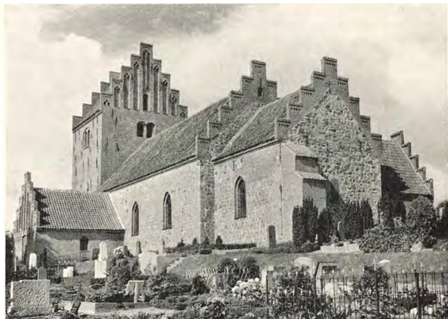
Den anselige romanske kæmpestenskirke i Højby i Odsherred med gotiske tilbygninger i teglsten.
