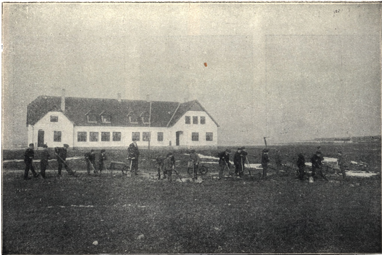
Det nybyggede Ourø Optagelseshjem 1900. — Drengene anlægge Veje.
