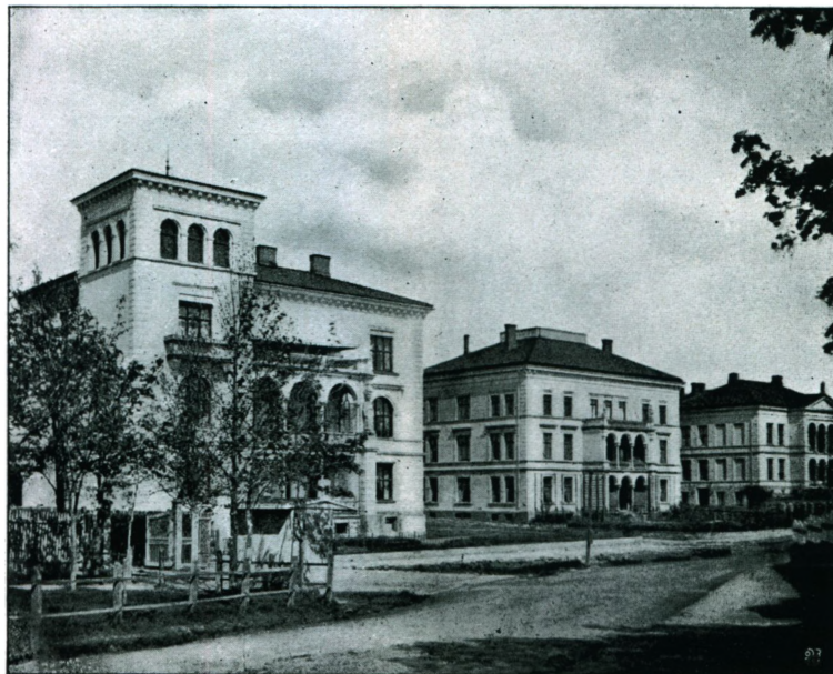
DRAMMENSVEIEN No. 21 og 23.
